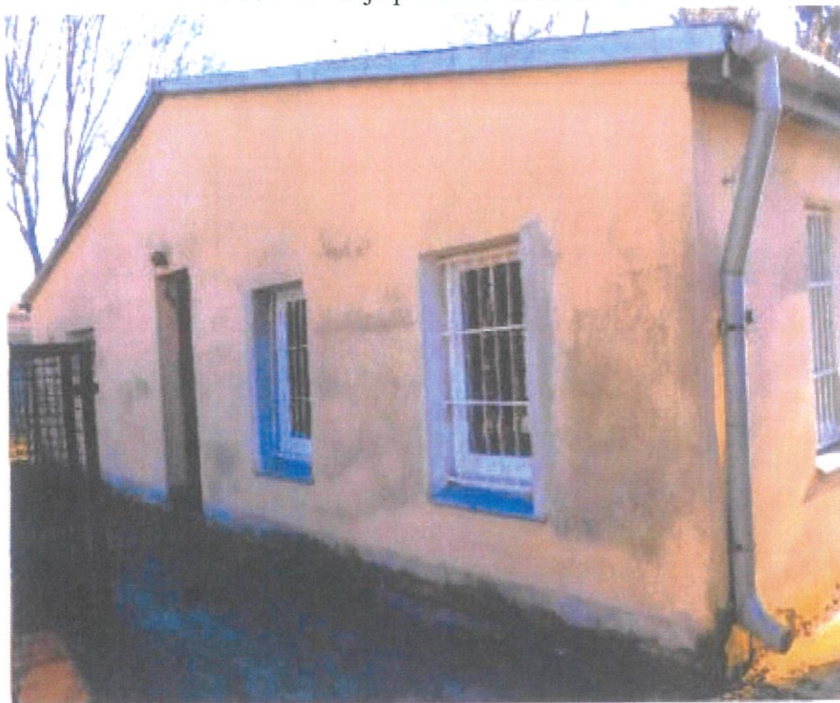
Fot. 3. Elewacja południowa bud. nr 10
