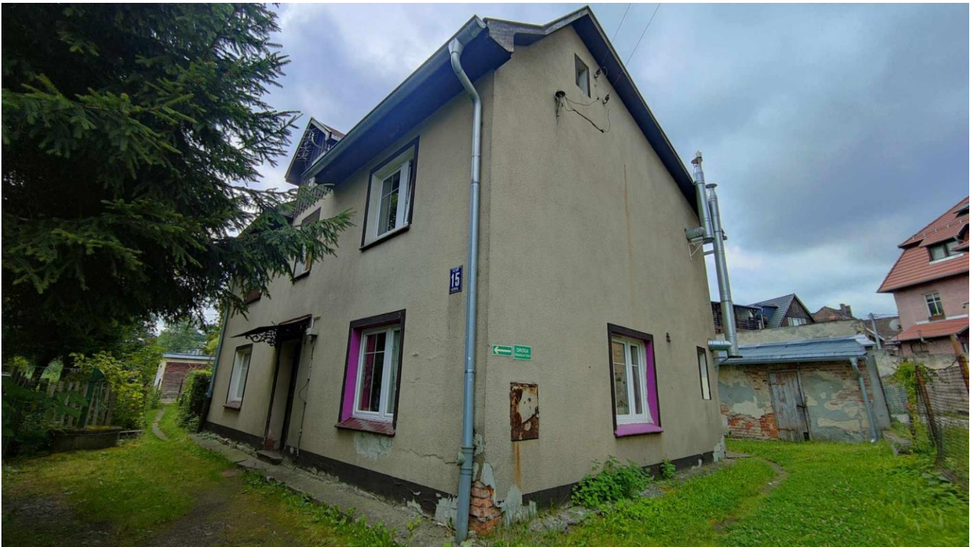
Zdjęcie budynku przy ul. Głównej 15 w Kudowie-Zdroju.
