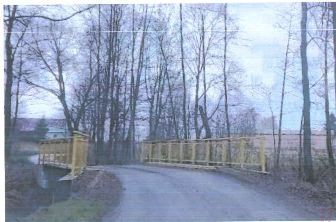
Zdjęcie nr 4: Istniejący obiekt mostowy w ciągu projektowanej drogi gminnej nr 112442L
