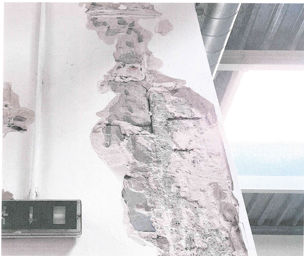
Fot. 7 Odkrywka nr 4, ściana podłużna, słup żelbetowy nieprzewiązany ze słupem
