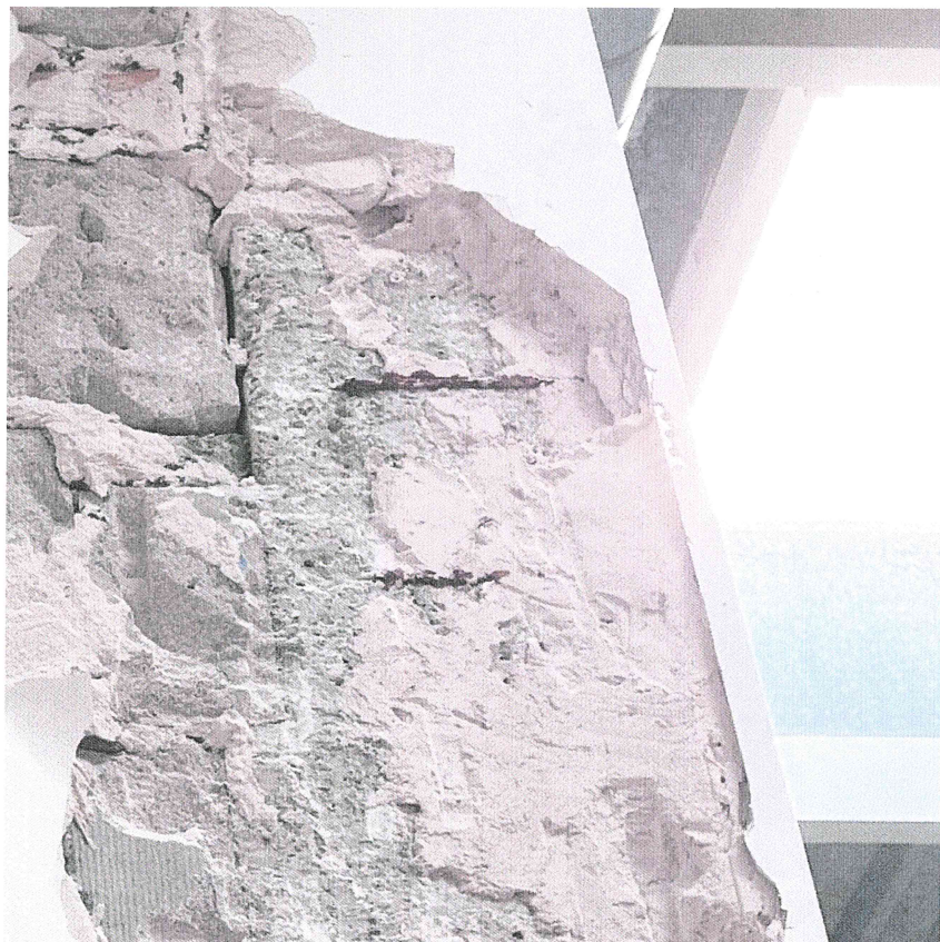
Fot. 2 Niedokładności wykonawcze, brak wymaganej otuliny, widoczne zbrojenie poprzeczne słupa
