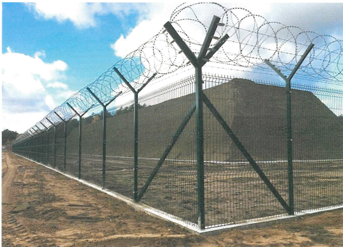
Fot. 1 Przykładowe ogrodzenie. Orientacyjna długość ogrodzenia około 2743 m.
