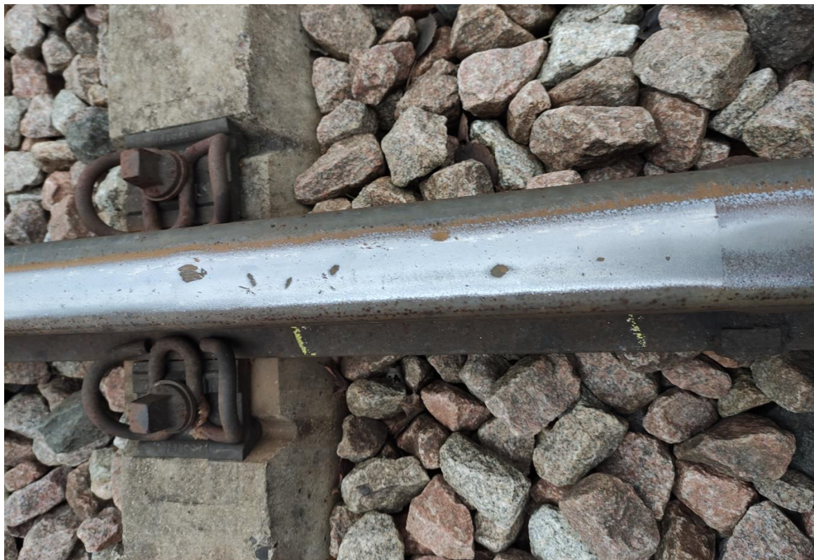
Rysunek 1 PKM Gdańsk km 6+900. Wykruszenia w torze nr 2 – lewy tok szynowy (do napawania)
