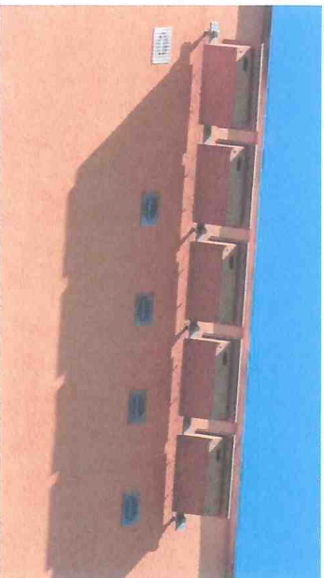
Ryc. 8. Przykładowy sposób zamocowania pięciu budek trocinobetonowych dla jeryka typ APK-1 do budynku – za pomocą płaskownika i kotew mocujących płaskownik do ściany budynku, przechodzących przez warstwę term izolacyjną.
