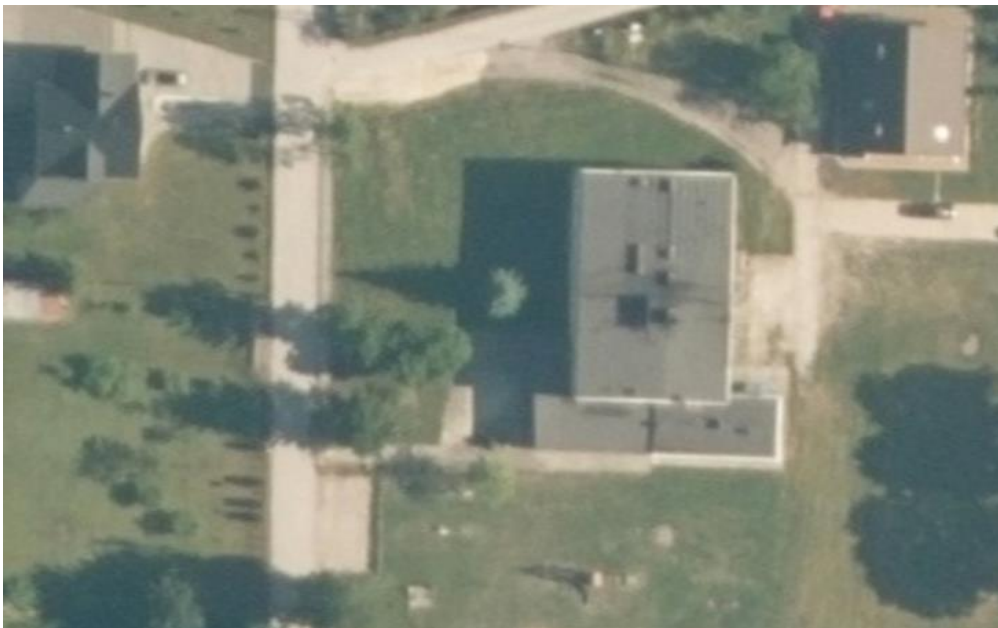
Budynek Zespołu Placówek Oświatowych nr 1, Filia w Łachowie, Łachów 75, 29-100 Włoszczowa
