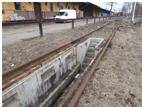
Fot. 2 Tor 10 kanał rewizyjny w torze
