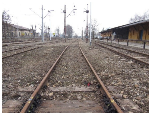
Fot. 6 Tor 12 - zanieczyszczona podsypka.
