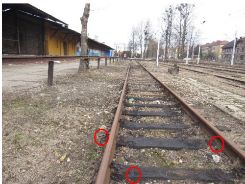
Fot. 1 Tor 10 - brak śrub stopowych
