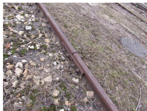
Fot. 12 Tor 14 - brak śrub łukowych.
