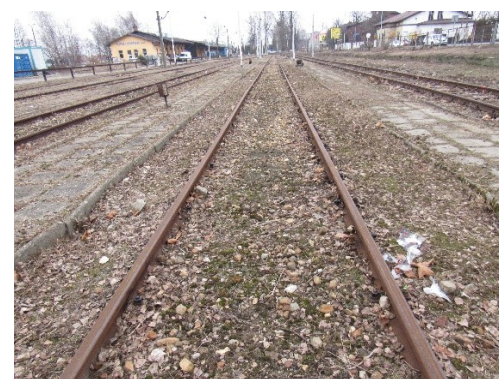
Fot. 14 Tor 16 - zanieczyszczona podsypka.
