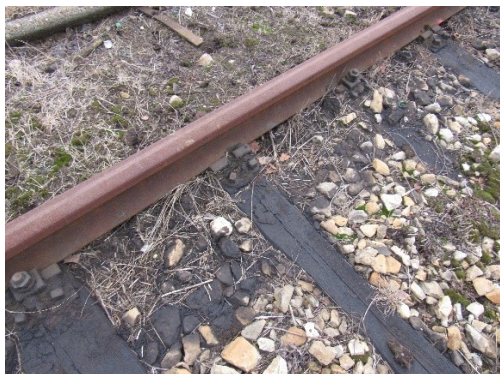
Fot. 5 Tor 12 - brak śrub stopowych.
