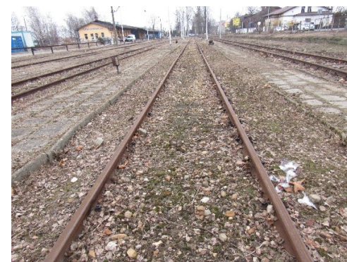
Fot. 14 Tor 16 - zanieczyszczona podsypka.
