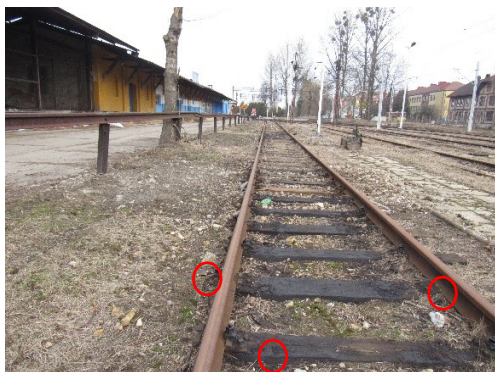
Fot. 1 Tor 10 - brak śrub stopowych
