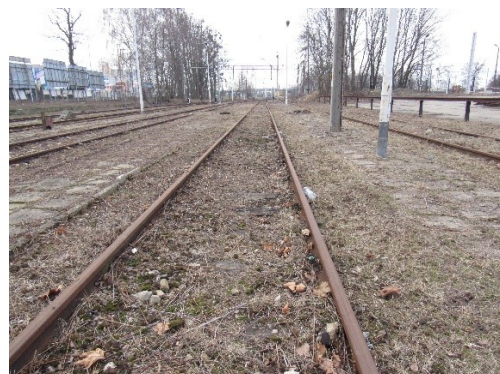
Fot. 7 Tor 12- zanieczyszczenia w torze.
