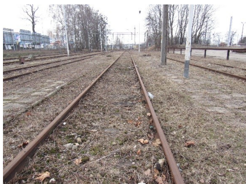
Fot. 7 Tor 12- zanieczyszczenia w torze.
