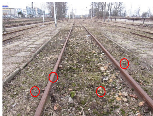
Fot. 10 Tor 14 - brak śrub stopowych.
