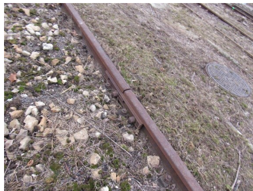
Fot. 12 Tor 14 - brak śrub łukowych.
