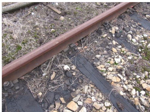
Fot. 5 Tor 12 - brak śrub stopowych.
