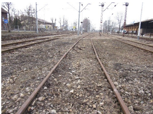
Fot. 9 Tor 14- zanieczyszczenia w torze.
