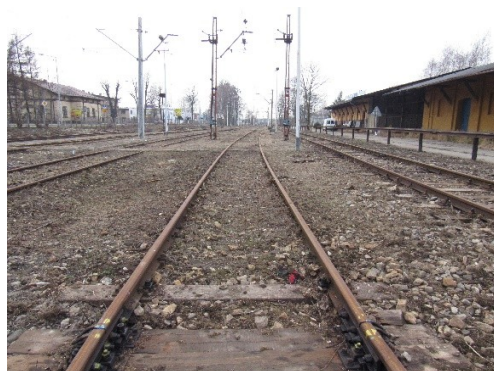
Fot. 6 Tor 12 - zanieczyszczona podsypka.
