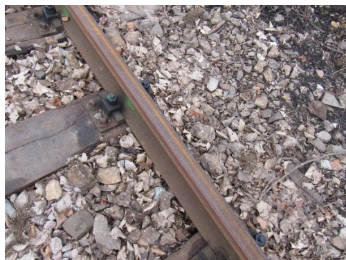
Fot. 18 Tor 18 - boczne zużycie szyny.
