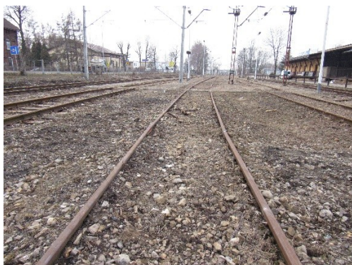
Fot. 9 Tor 14- zanieczyszczenia w torze.
