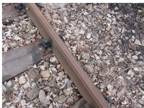
Fot. 18 Tor 18 - boczne zużycie szyny.
