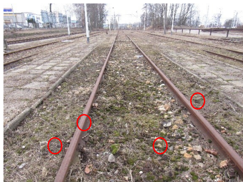
Fot. 10 Tor 14 - brak śrub stopowych.
