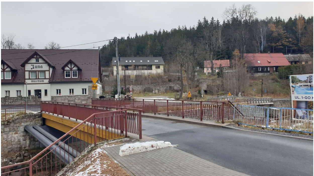
Rys. 5 Latarnia nr 19 widok 1
