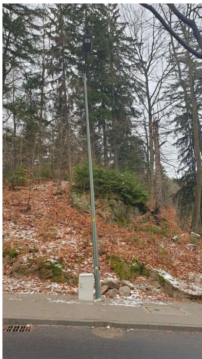
Rys. 1 Latarnia nr 18 widok latarni
