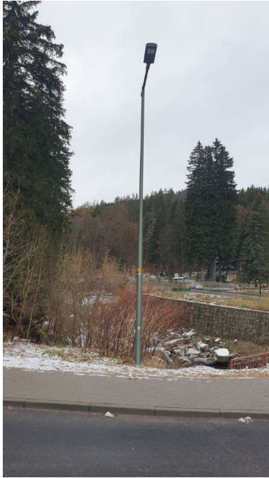
Rys. 4 Latarnia nr 19 widok latarni
