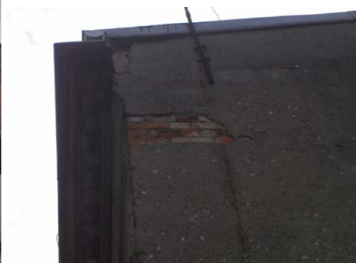
Zdj. 10 Ubytki na elewacji bocznej (BC)
