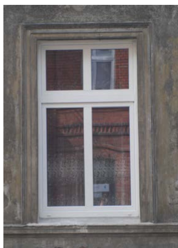
Zdj.5 Wymieniona stolarka okienna (elew.front.)
