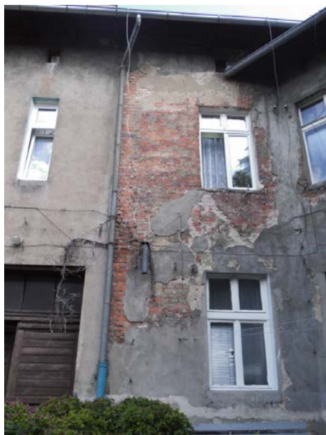
Zdj. 18 Ubytki tynku na elewacji tylnej
