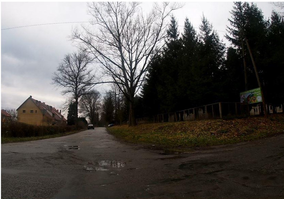
Zdj. nr 5 Odcinek drogi nr 3326 D
