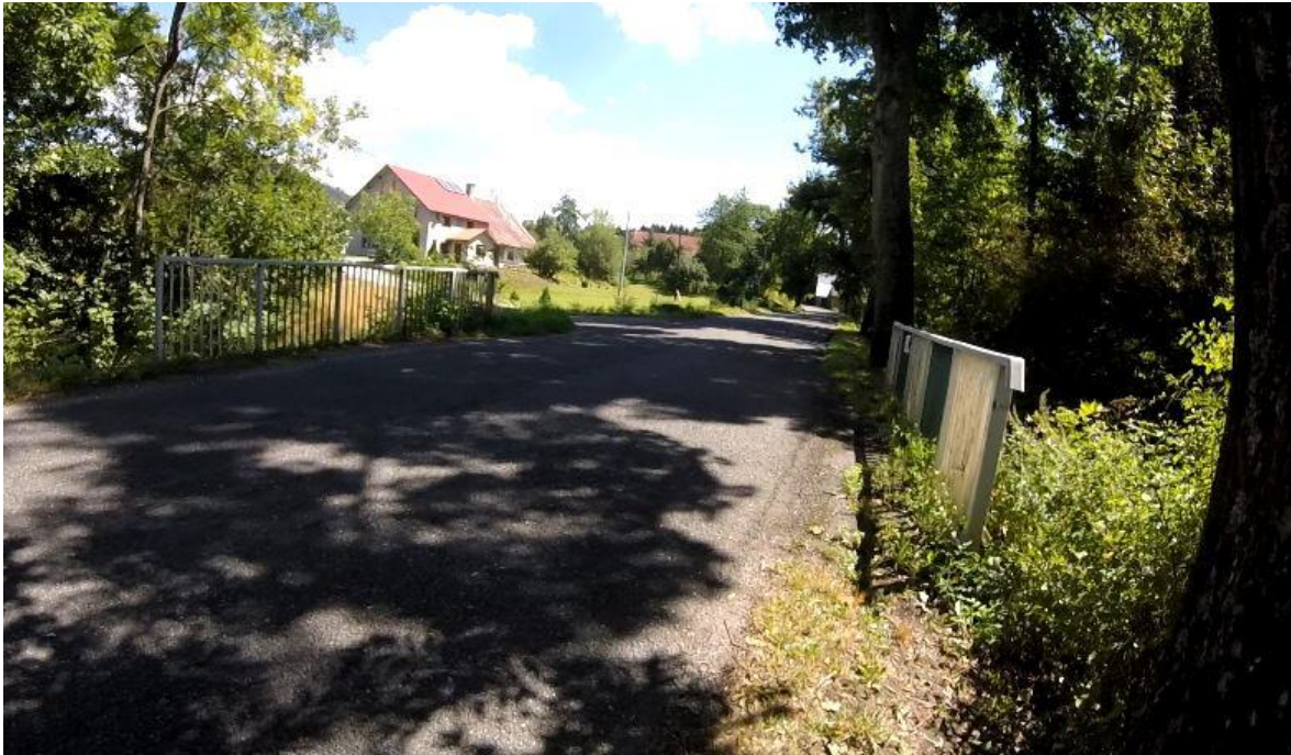
Zdj. nr 5 Koniec projektowanego odcinka
