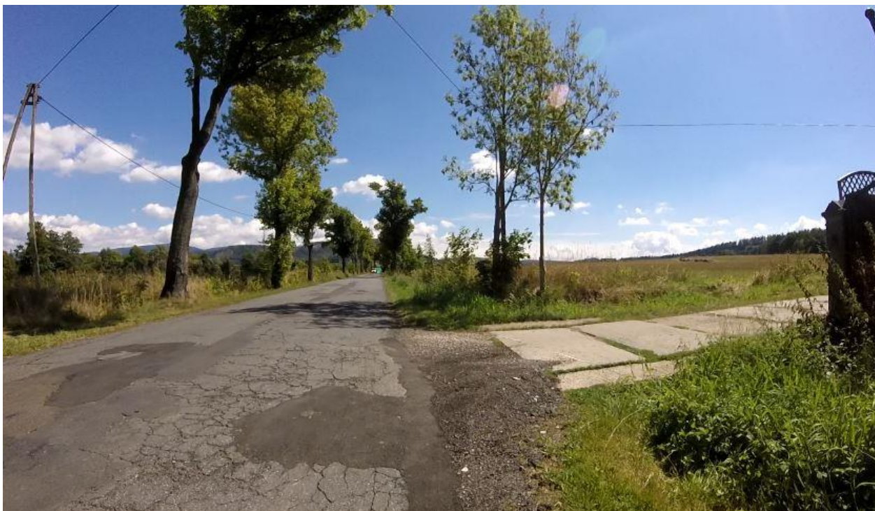
Zdj. nr 2 Początkowy odcinek drogi
