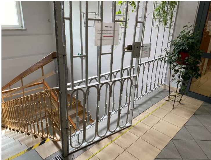
Zdj. 5 Widok balustrady na ostatnim poziomie
