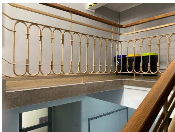
Zdj. 1 Widok balustrady na poziomie spocznika
