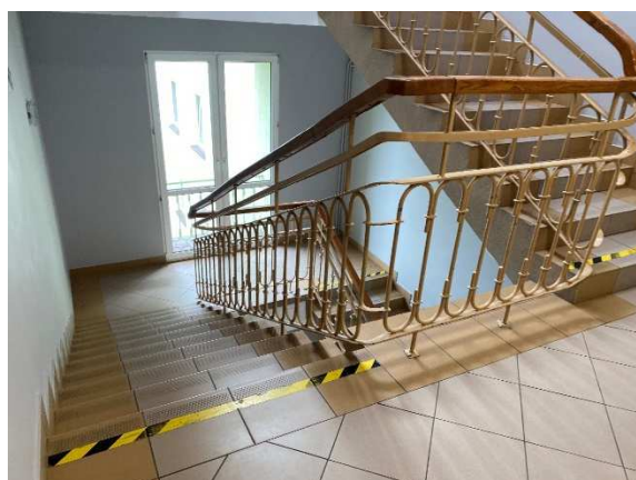
Zdj. 4 Widok balustrady
