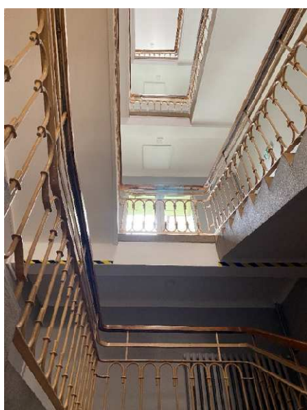
Zdj. 1 klatki schodowa - widok z dołu
