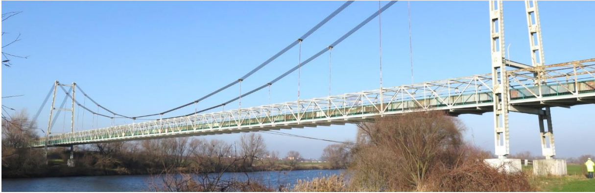
Fot. 2. Widok na przęsło nurtowe z prawego brzegu
