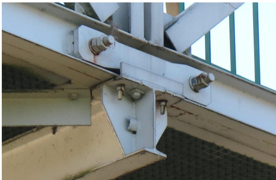
Fot. 5. Uciągnięcie pasów dolnych po przeprowadzonych robotach remontowych (po roku 2014)
