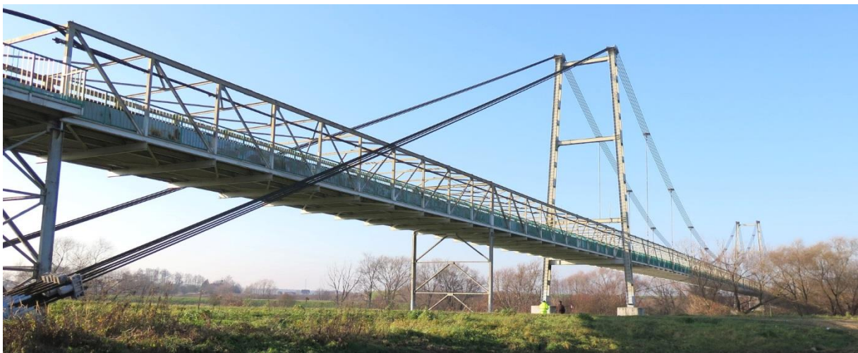
Fot. 1. Widok na most z prawego brzegu, na pierwszym planie przęsła skrajne 2 \times 30\text{m} oraz zakotwienie lin nośnych w bloku kotwiącym
