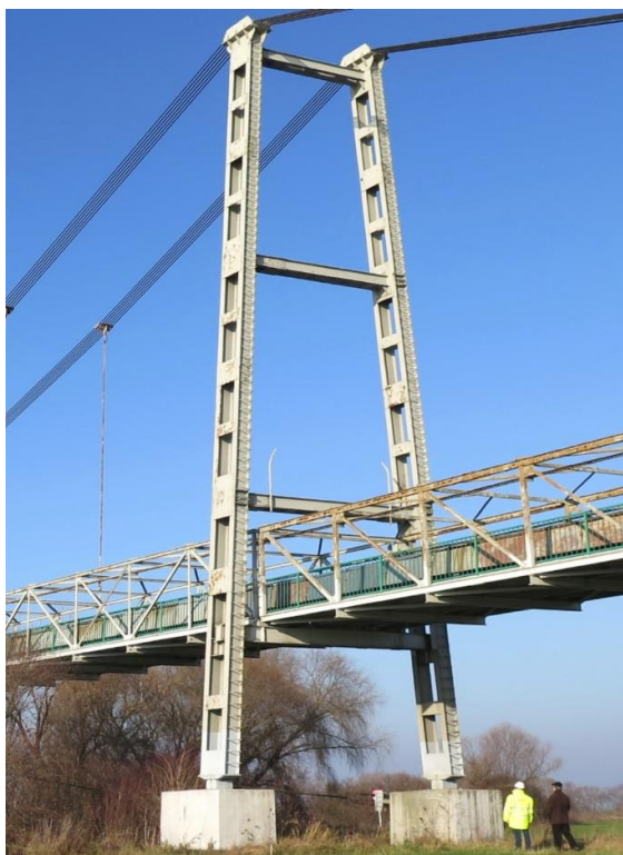
Fot. 3. Widok na pylon na prawym brzegu
