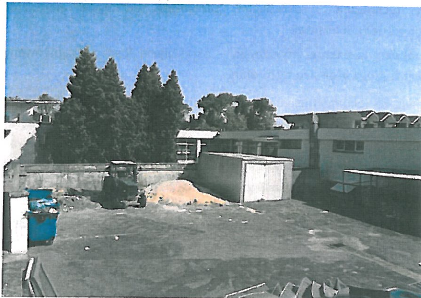
Zdj. nr 9. Plac wewnętrzny.
