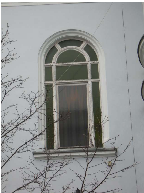
Fot. 27 i 28 - Istn. okno krosnowe w klatce schodowej – widok od strony zewnętrznej (elewacja pld) i wewnętrznej, widoczna różnica w szerokości ramiaków okna w części górnej półkolistej i dolnej prostokątnej, stan zachowania średni, w dolnej części złuszczenia farby, spękania drewna, zniszczenia (poprzez zawilgocenie) okapnika stalowego (destrukcja blachy okapnikowej przez rdzę)
