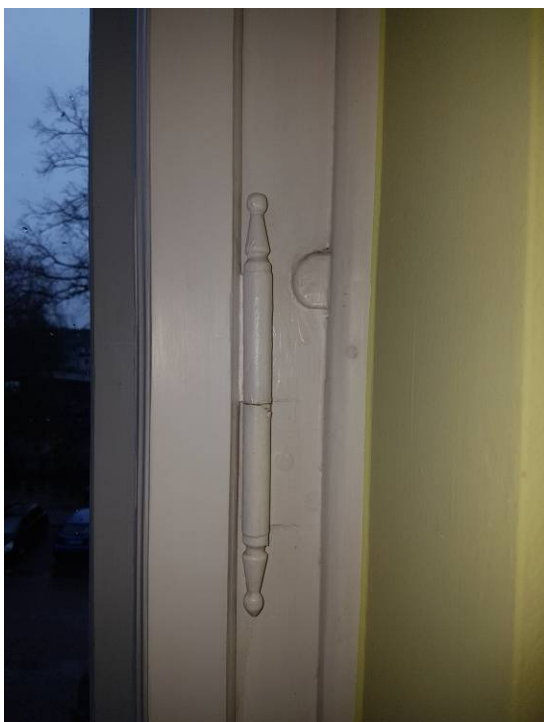
Fot. 6 i 7 - Istn. okno jednoskrzydłowe – okucia oryginalne: zawias okienny i klamka okienna (pom. sali ślubów), stan zachowania - dobry
