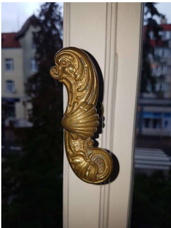
Fot. 21 i 22 - Istn. okno dwuskrzydłowe – widok istniejących okuć oryginalnych, stan zachowania - dobry
