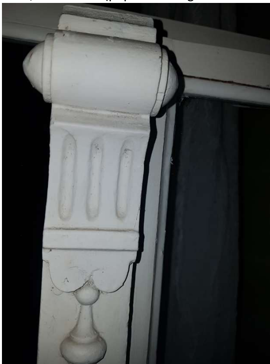
Fot. 15 i 16 - Istn. okno dwuskrzydłowe – widok na listwy przymykowe dekoracyjne od zewnątrz – sala ślubów, stan zachowania: w górnej i środkowej części stan dobry, w dolnej średni/zły
