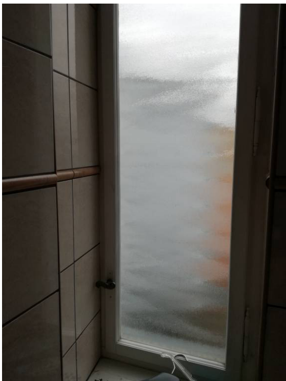
Fot. 24 i 25 - Istn. okno dwuskrzydłowe krosnowe – widok od strony wewnętrznej (pom. gospodarcze WC), stan zachowania średni, w dolnej części złuszczenia farby, spękania drewna, zniszczenia (poprzez zawilgocenia drewna) okapników drewnianych
