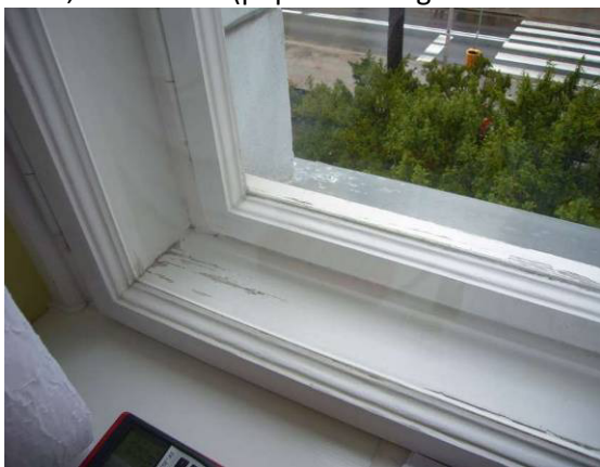
Fot. 13 i 14 - Istn. okno dwuskrzydłowe – widok od wewnątrz – sala ślubów, stan zachowania średni/zły: złuszczenia farby, spękania drewna, szczególnie w dolnej części okna, zniszczenia (poprzez zawilgocenia drewna) okapników drewnianych
