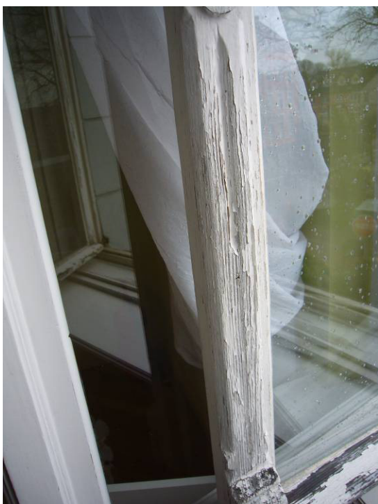
Fot. 19 i 20 - Istn. okno dwuskrzydłowe – widok na listwy przymykowe dekoracyjne od zewnątrz – sala ślubów, stan zachowania: w górnej i środkowej części stan zachowania dobry, w dolnej części złuszczenia farby, spękania drewna, zniszczenia (poprzez zawilgocenia drewna) okapników drewnianych, ślady zagłonicenia
