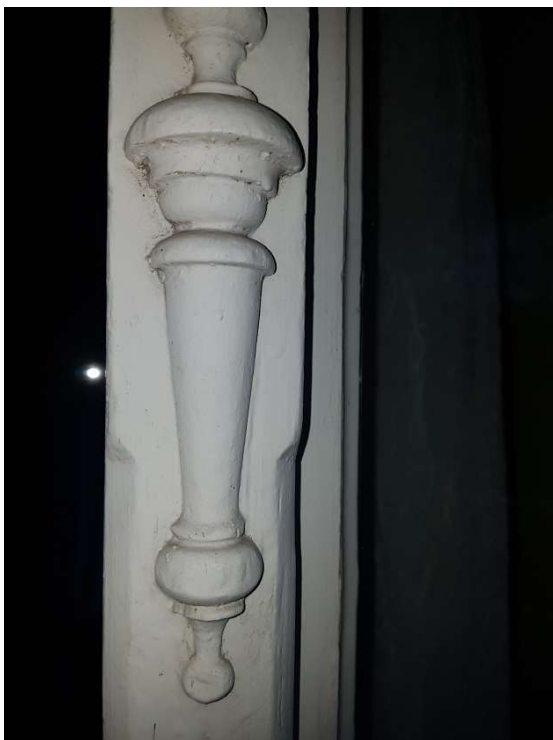
Fot. 17 i 18 - Istn. okno dwuskrzydłowe – widok na listwy przymykowe dekoracyjne od zewnątrz – sala ślubów, stan zachowania: w górnej i środkowej części stan dobry, w dolnej średni/zły
