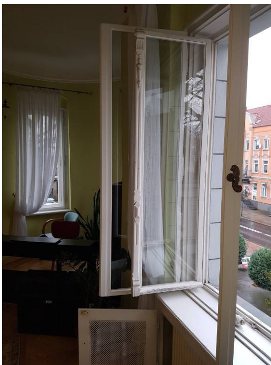
Fot. 9 i 10 - Istn. okno dwuskrzydłowe – widok od wewnątrz – sala ślubów, stan zachowania średni/zły: złuszczenia farby, spękania drewna, szczególnie w dolnej części okna, wtórne obudowy grzejników bez kratki nawiewnych w parapetach okiennych
