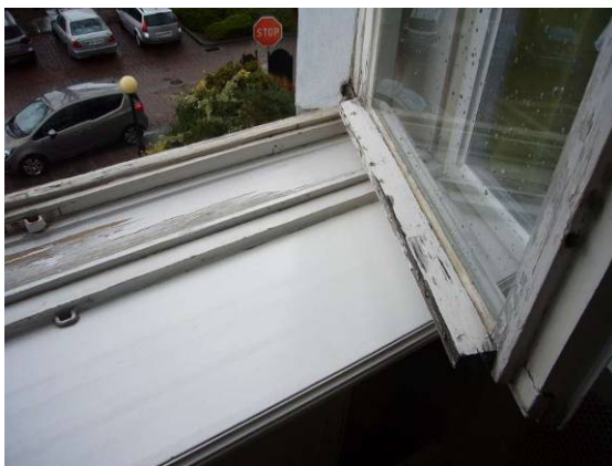
Fot. 11 i 12 - Istn. okno dwuskrzydłowe – widok od wewnątrz – sala ślubów, stan zachowania średni/zły: złuszczenia farby, spękania drewna, szczególnie w dolnej części okna, zniszczenia (poprzez zawilgocenia drewna) okapników drewnianych
