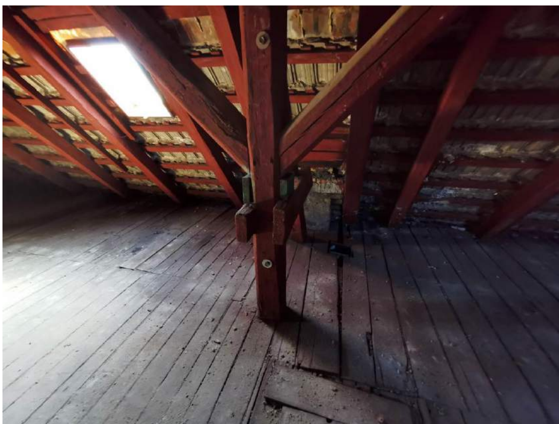
Fot.14. Zbliżenie na miecze - widoczne pęknięcie podłużne powodujące spadek właściwości mechanicznych elementu.
