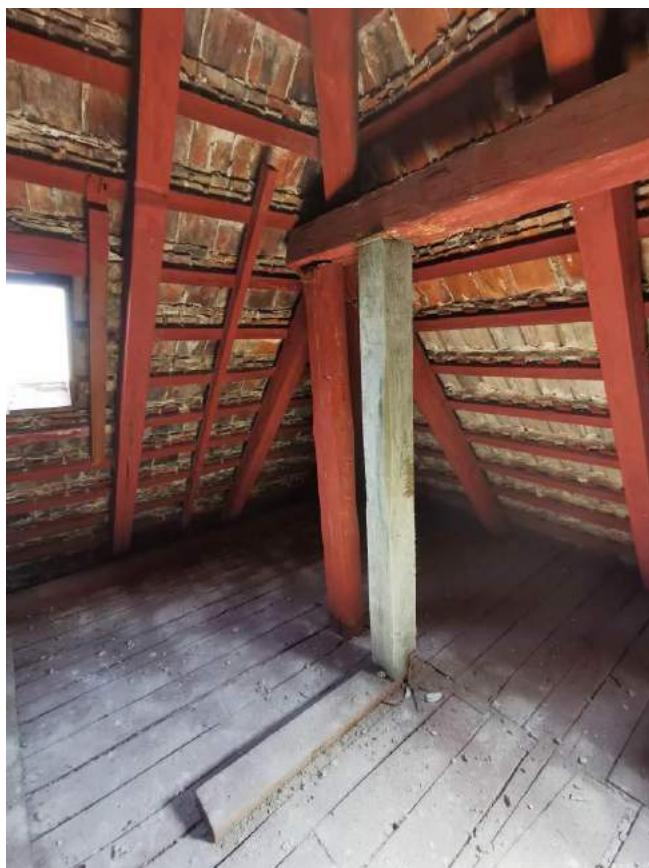
Fot.17. Widok na słup konstrukcyjny wraz z zastosowanym wzmocnieniem w postaci dodatkowego słupa.
