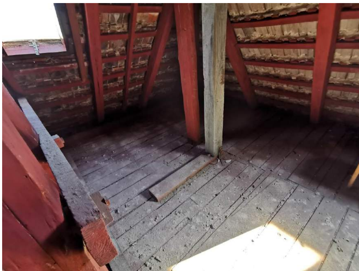
Fot.16. Widok na słup wraz z zastosowanym wzmocnieniem.
