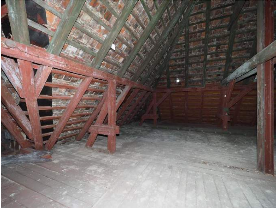
Fot.1. Widok ogólny więźby dachowej widoczne różne kolory impregnatu
