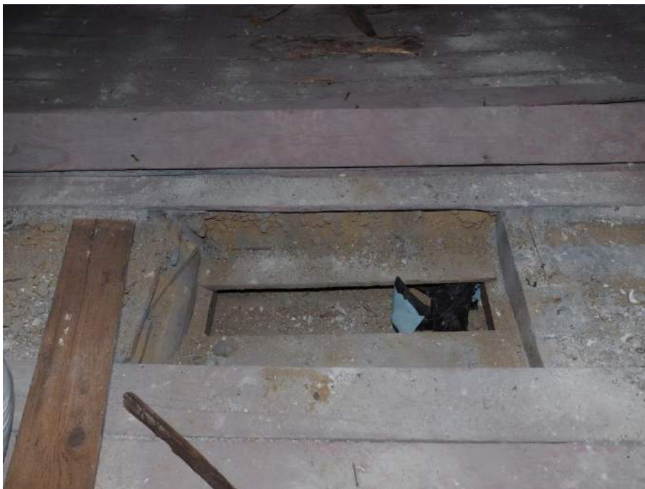
Fot.5. Odkrywka podłogi poddasza
