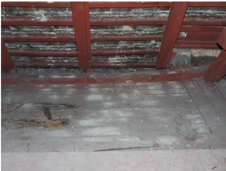
Fot.3. Odeskowanie porażone przez grzyby w formie nieaktywnej
