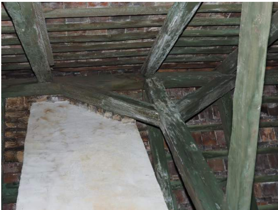
Fot.7. Wysolenia na powierzchni drewna
