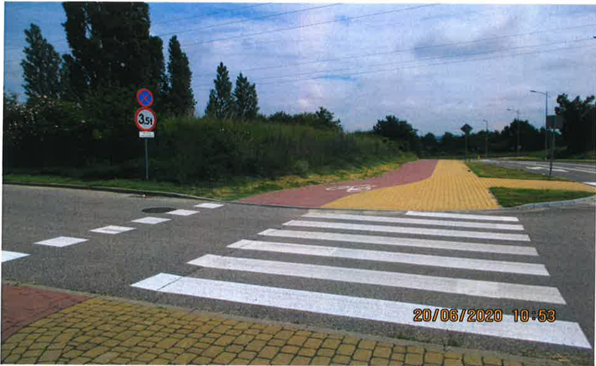
WLOT UL. ROGOZINSKIEGO DO SKRZYZOWANIA - ISTN. OZNAKOWANIE PIONOWE POZIOME JEZDNI PZRECIWLEGA
