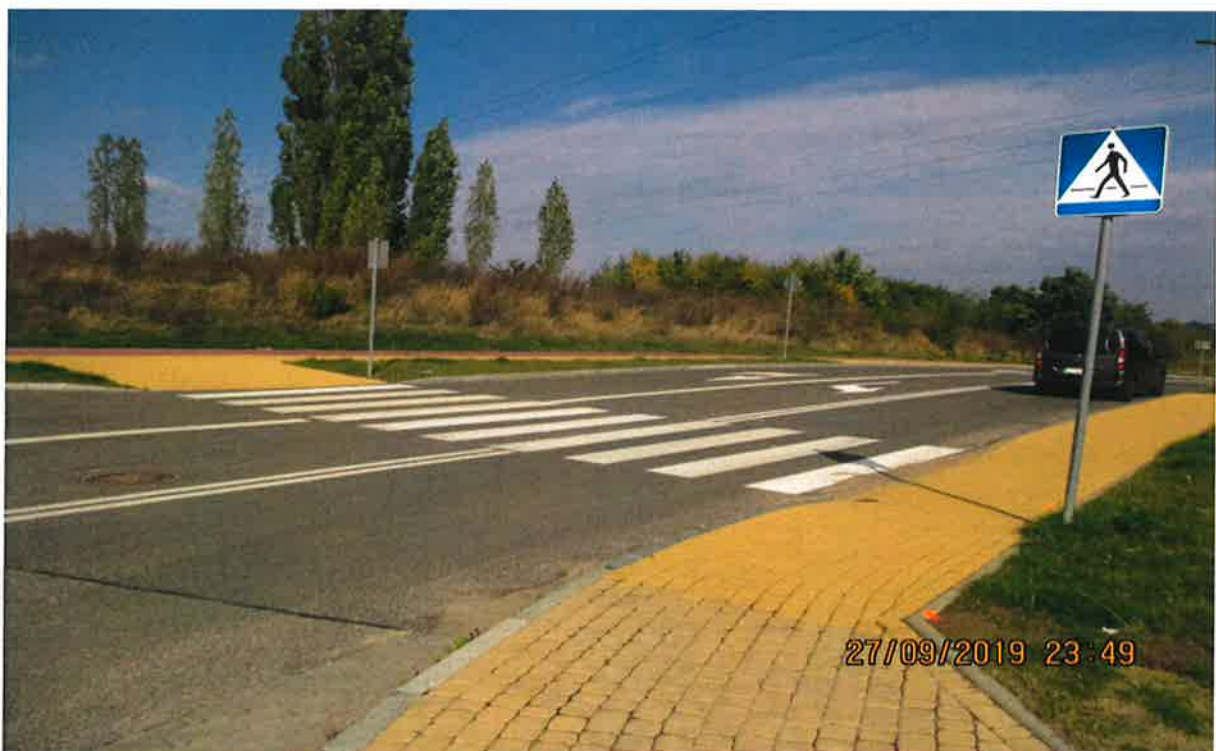
UL. STZRELECKIEGO – ISTN . OZNAKOWANIE PIONOWE I POZIOME PRZEJSCIA PIESZEGO WIDOK OD STRONY JEZDNI PRZECIWLEGŁEJ
