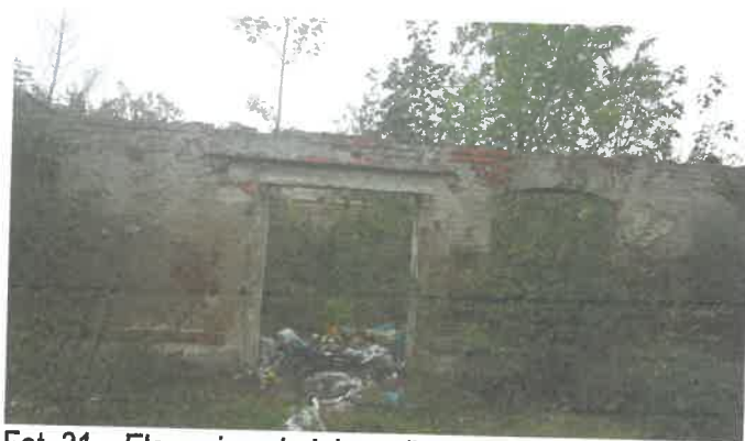
Fot. 31 – Elewacja południowa (budynek bez dachu)
