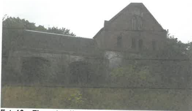
Fot. 12 – Elewacja północna
