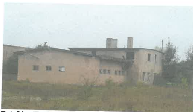
Fot. 21 – Elewacja pln./wsch.
