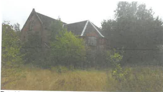
Fot. 11 – Elewacja półn./zach.
