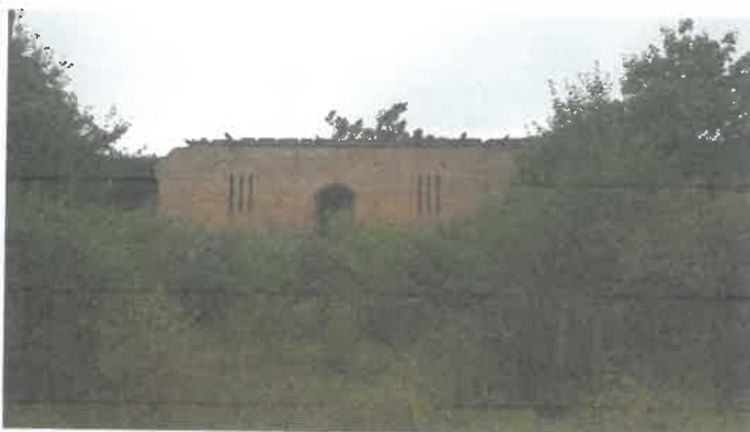
Fot. 16 – Elewacja północna
