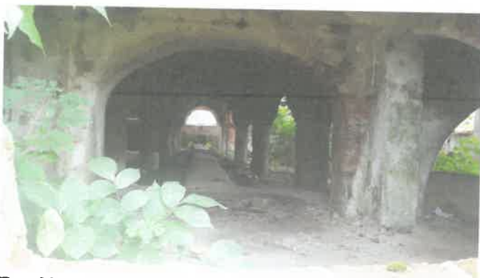
Fot. 23 – Wnętrze stajni
