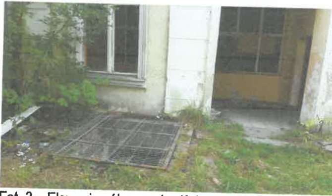
Fot. 3 – Elewacja północna (wejście do budynku)
