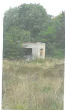
Fot. 34 – Budynek dyżurki – Elewacja połd./zach.
