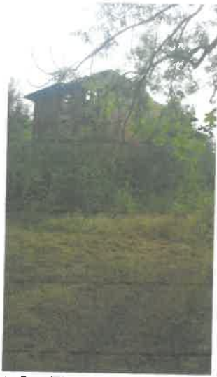
Fot. 8 – Elewacja półn./wsch.
