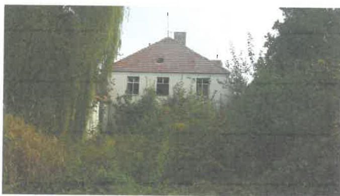
Fot. 6 – Elewacja zachodnia
