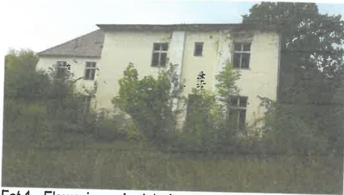
Fot.1 - Elewacja wschodnia (taras + piwnica)
