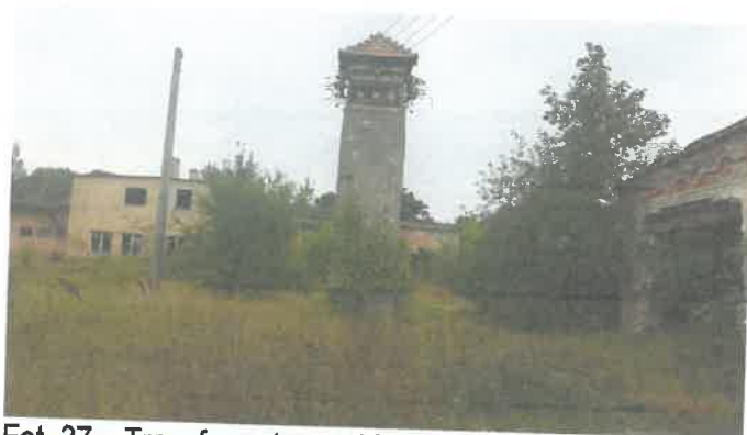
Fot. 37 – Transformator – widok ogólny
