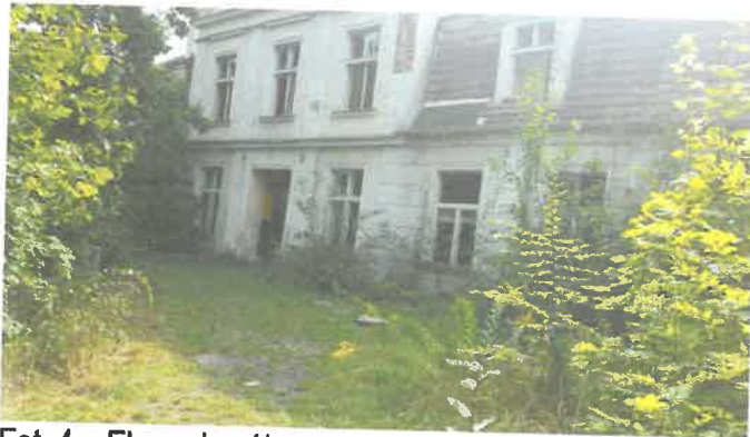
Fot. 4 – Elewacja północna
