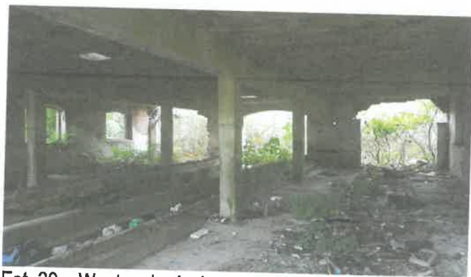
Fot. 30 – Wnętrze budynku
