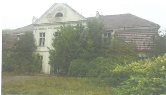
Fot. 7 – Elewacja południowa
