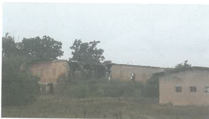
Fot. 18 – Elewacja północna (widok ogólny)
