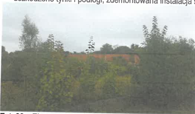
Fot. 22 – Elewacja zachodnia
