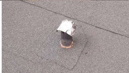
Zdjęcia przedstawiają kominy wentylacyjne murowane i wyrzutnie stalową oraz skorodowane kominki wentylacji kanalizacyjnej na budynku kuchni.
