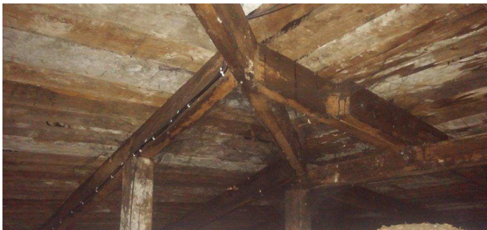
Fot 4 Konstrukcja więźby dachowej.
