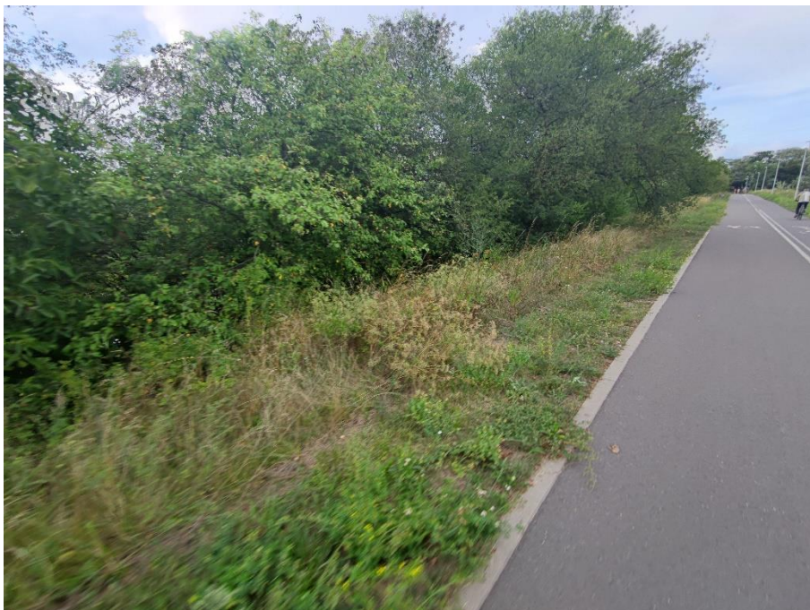
Fot.10. Widok na skarpe odpowietrzną oraz koronę wału w km 0+650. Widoczne krzewy i drzewa na skarpie wału.
