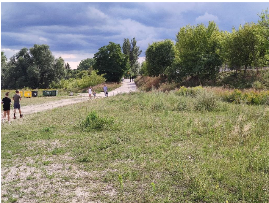
Fot.13. Widok na skarpe odwodną oraz zjazd na międzywale w km 0+040. Widoczne krzewy i drzewa na skarpie wału.
