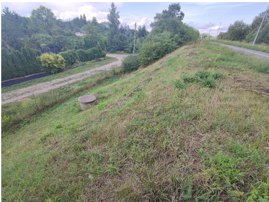
Fot.6. Widok na skarpe odpowietrzną wału w km 1+020. Widoczne krzewy i drzewa na skarpie wału.
