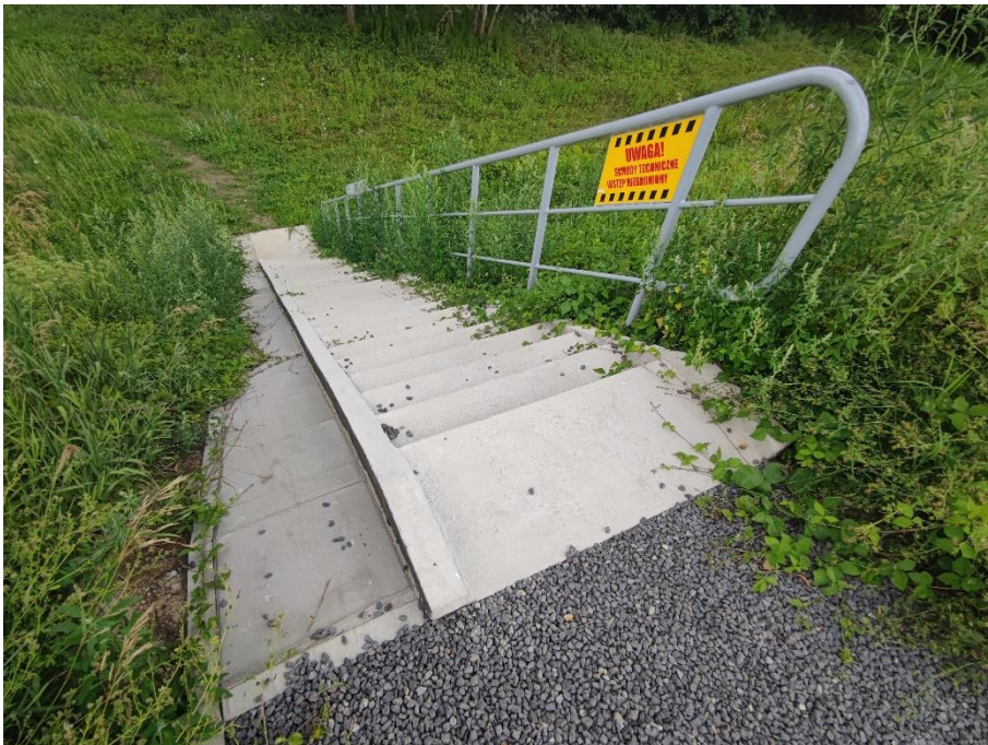
Fot.7. Widok na schody skarpowe od strony międzywala w km 1+026. Stan schodów dobry.
