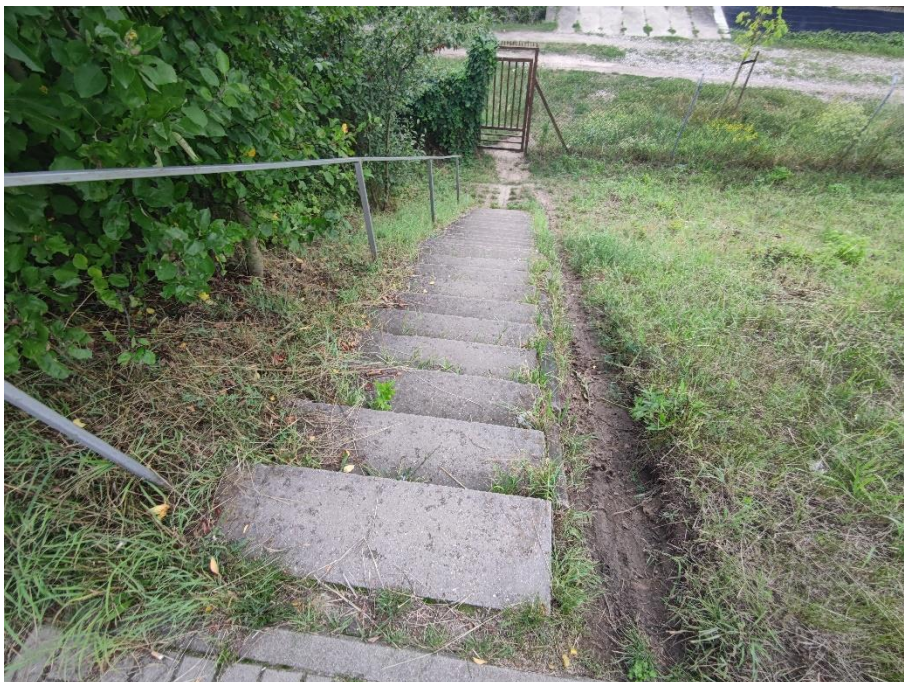
Fot.5. Widok na schody skarpowe od strony zawala w km 1+026. Stan schodów dobry. Widoczne krzewy i drzewa na skarpie wału.
