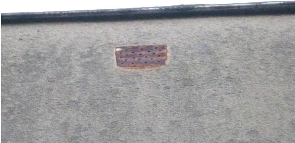
Foto.26. Zabezpieczony otwór wentylacyjny stropodachu na budynku „C”. Fot. Przemysław Kubacki.
