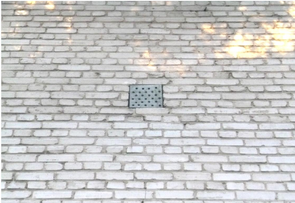
Foto.16. Zabezpieczony otwór wentylacyjny sali gimnastycznej. Fot. Przemysław Kubacki.
