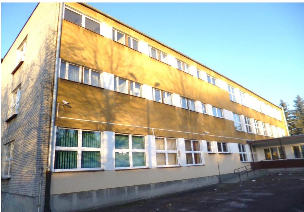
Foto.10. Wschodnia elewacja budynku „A” widok od strony południowej. Fot. Przemysław Kubacki.
