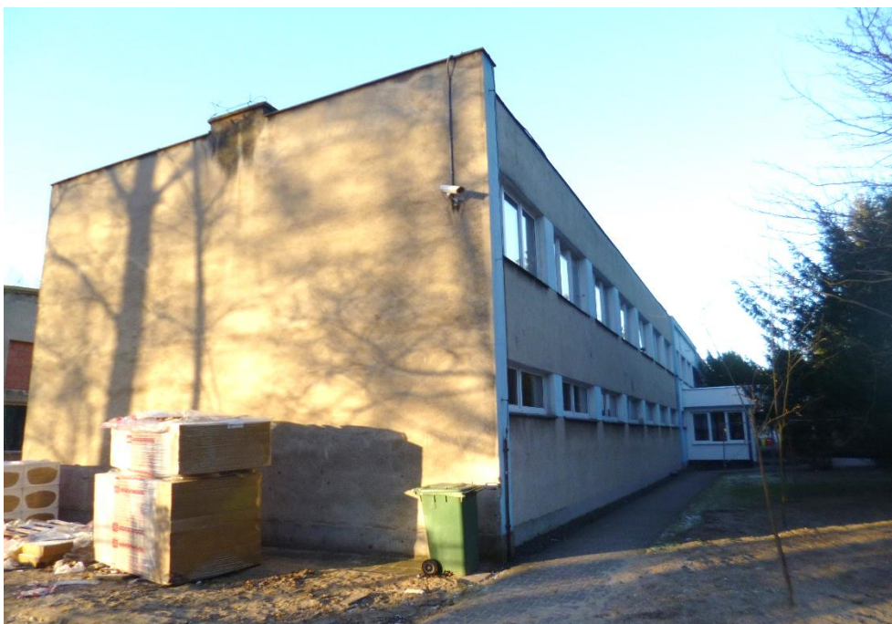
Foto.24. Budynek „C”, widok od strony północno-wschodniej. Fot. Przemysław Kubacki.
