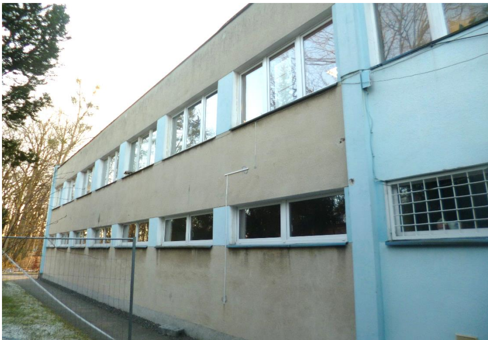
Foto.23. Północna ściana budynku „C”, część wschodnia. Fot. Przemysław Kubacki.
