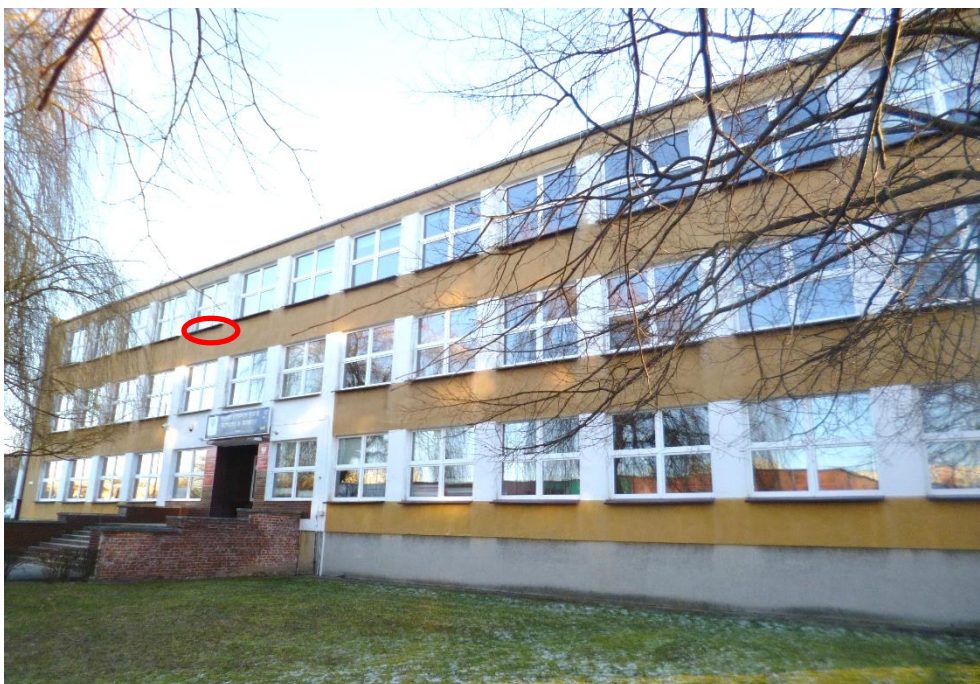
Foto.5. Zachodnia elewacja budynku „A” z zaznaczonym siedliskiem wróbla. Fot. Przemysław Kubacki.
