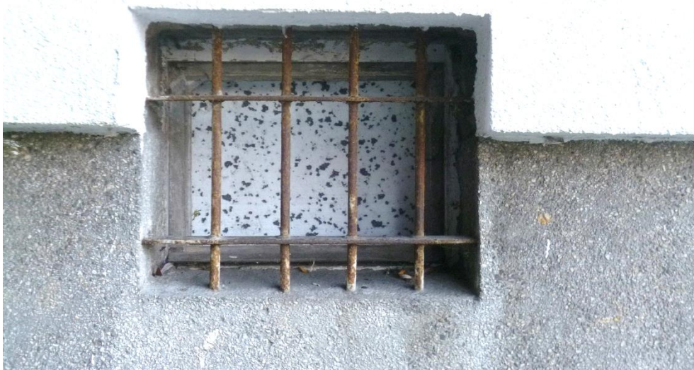
Foto.2. Okno piwnicy na północnym szczycie budynku „A”. Fot. Przemysław Kubacki.
