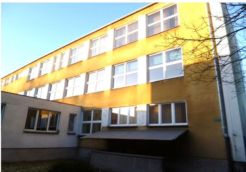
Foto.11. Wschodnia elewacja budynku „A”, widok od strony północnej. Fot. Przemysław Kubacki.
