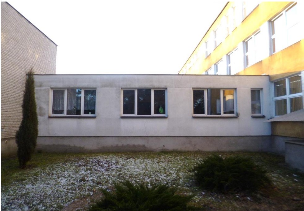
Foto.19. Łącznik sali gimnastycznej z budynkiem „A”, widok od strony północnej. Fot. Przemysław Kubacki.
