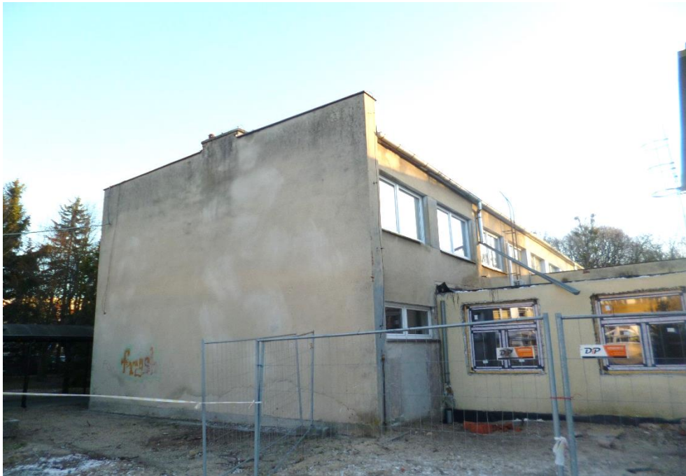
Foto.20. Budynek „C”, widok od strony południowo-zachodniej. Fot. Przemysław Kubacki.
