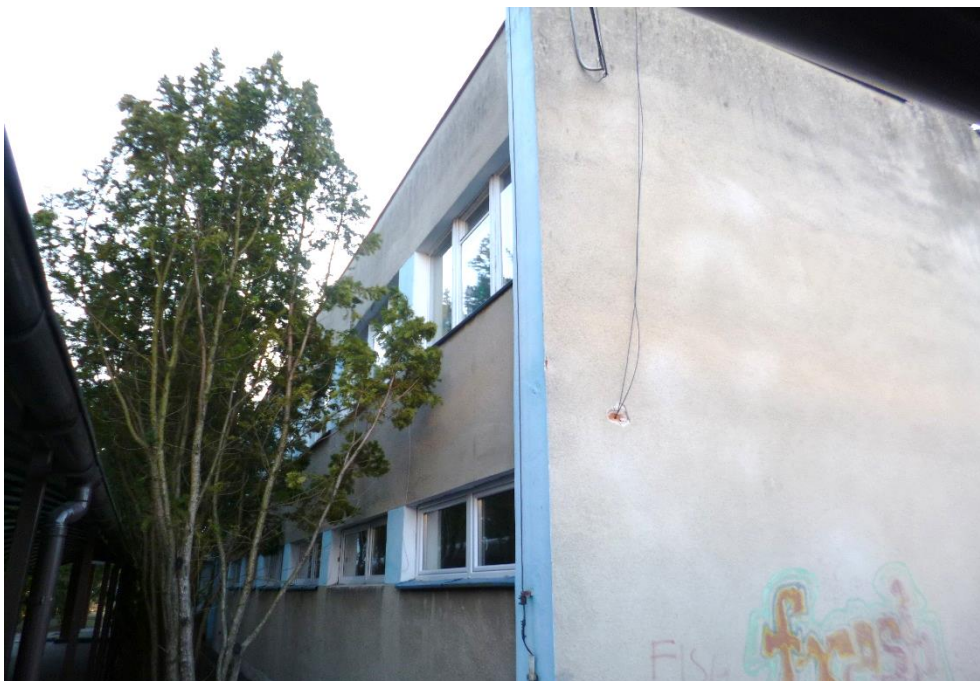
Foto.21. Budynek „C” widok od strony północno-zachodniej. Fot. Przemysław Kubacki.
