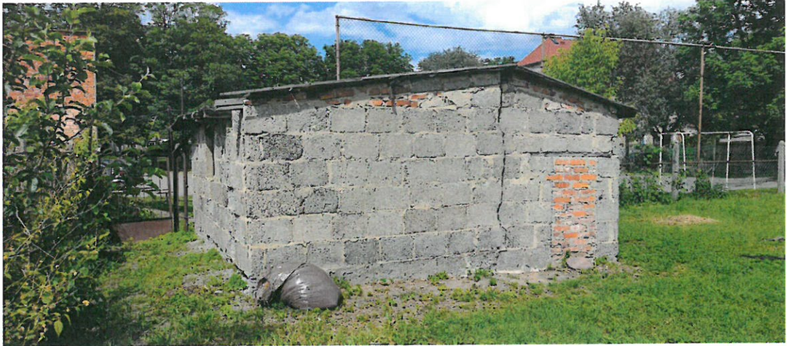
Fot. 2 Widok budynku od tyłu
