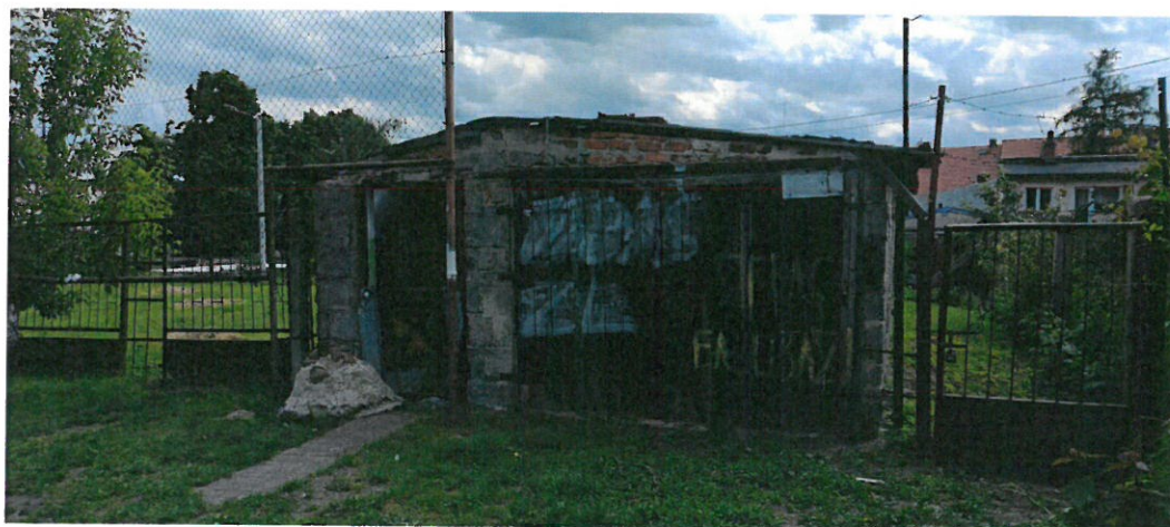
Fot. 1 Widok budynku od frontu
