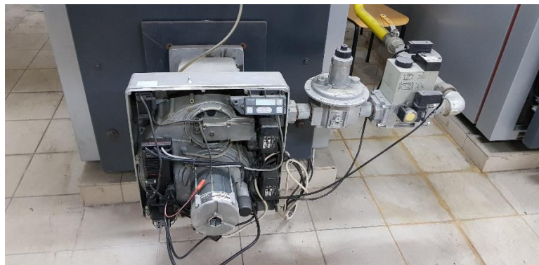
rys. 3 palnik gazowy wyposażony w kompletną ścieżkę gazową z filtrem i zaworem odcinającym.
