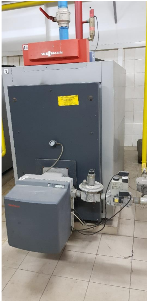
rys. 10 widok ogólny. Kocioł jest w stanie bardzo dobrym. Wszystkie urządzenia są kompletne. W chwili obecnej kocioł jest zalany wodą pod ciśnieniem. Kocioł posiada również tłumik dźwięku (rys. 5)
