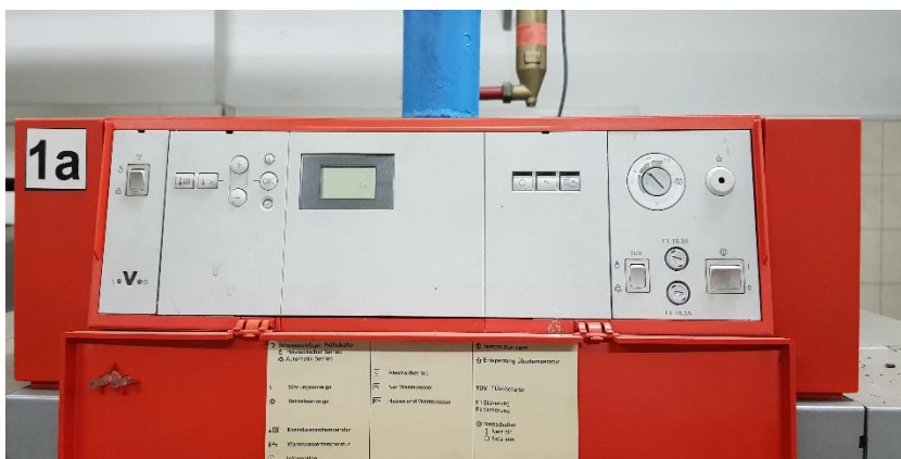
rys. 10 widok ogólny. Kocioł jest w stanie bardzo dobrym. Wszystkie urządzenia są kompletne. W chwili obecnej kocioł jest zalany wodą pod ciśnieniem. Kocioł posiada również tłumik dźwięku (rys. 5)
