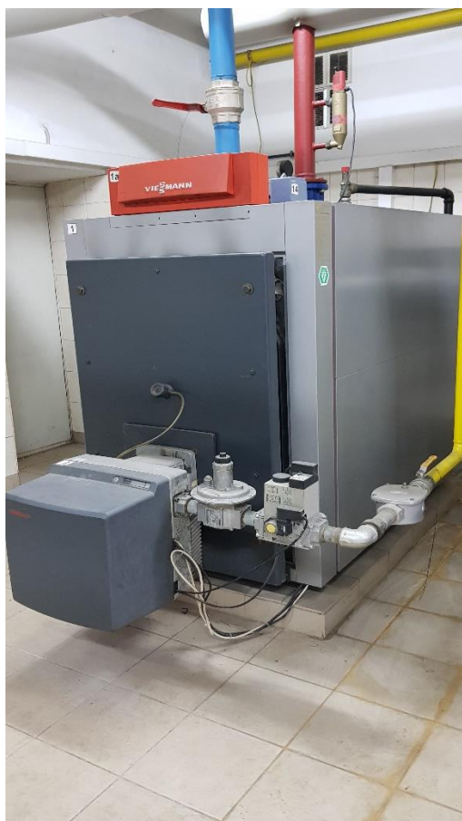
rys. 1 widok ogólny. Kocioł jest w stanie bardzo dobrym. Wszystkie urządzenia są kompletne. W chwili obecnej kocioł jest zalany wodą pod ciśnieniem.
