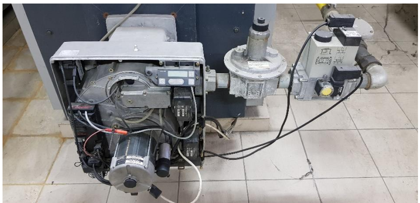
rys. 12 palnik gazowy wyposażony w kompletną ścieżkę gazową z filtrem i zaworem odcinającym.
