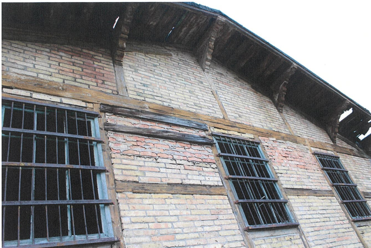
ZDJ. 39 GIŻYCKO, TWIERDZA BOYEN, BUDYNEK ĆWICZEŃ. ELEWACJA PŁD-WSCH. PRZEMUROWANIA
