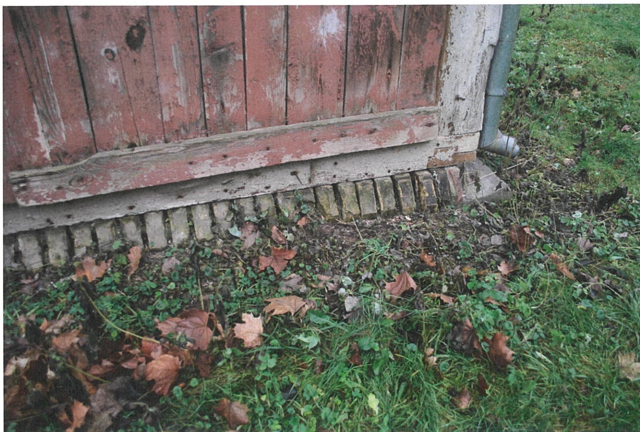
ZDJ. 34; 35 GIŻYCKO, TWIERDZA BOYEN, BUDYNEK ĆWICZEŃ. PODNIESIONY POZIOM TERENU I PODLEWANIE FUNDAMENTÓW WODĄ Z RUR SPUSTOWYCH
