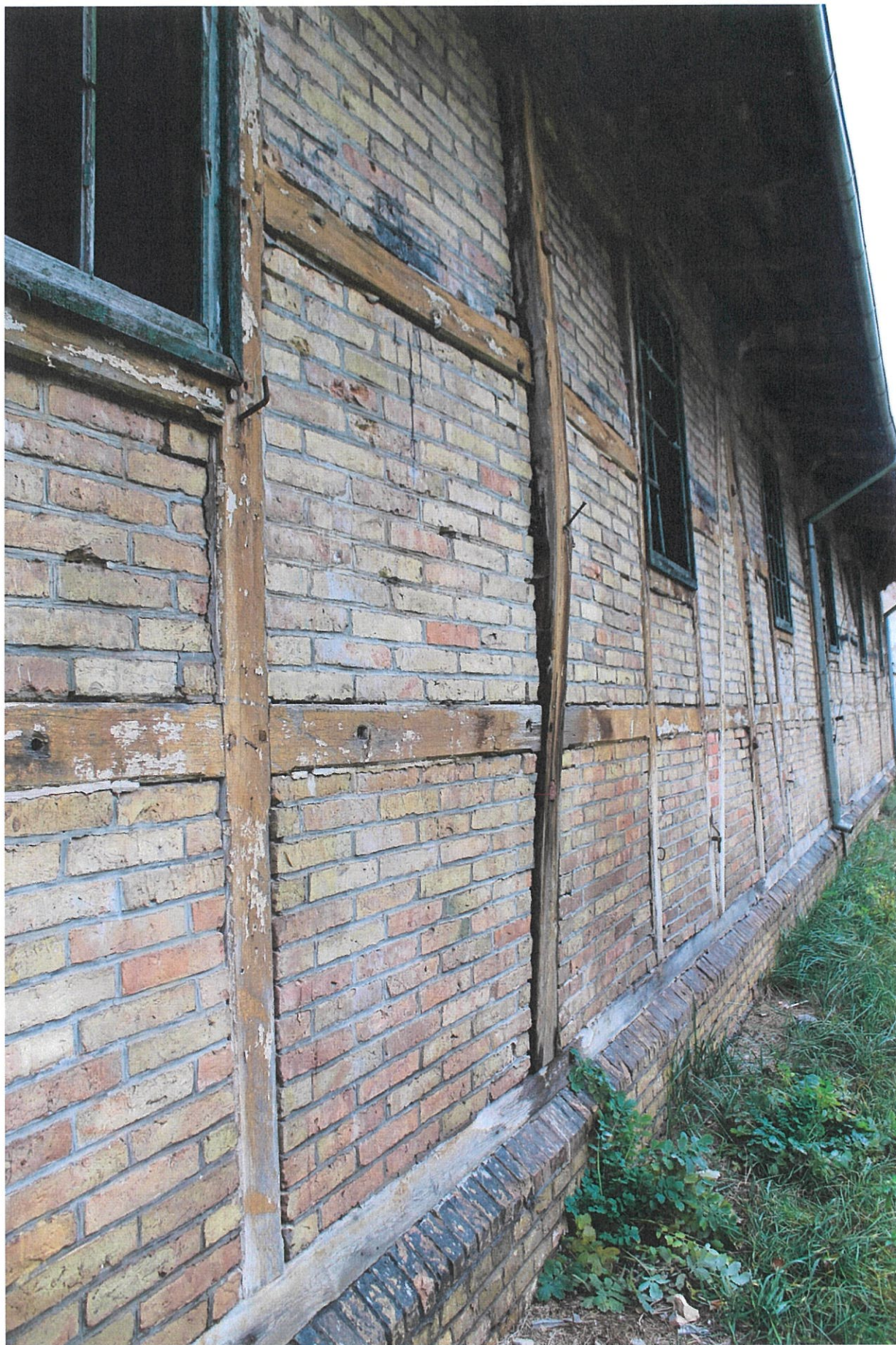
ZDJ. 36 GIŻYCKO, TWIERDZA BOYEN, BUDYNEK ĆWICZEŃ. ELEWACJA PŁD-ZACH. WYPCHNIĘCIE SŁUPA I WYBRZUSZENIE ŚCIANY
