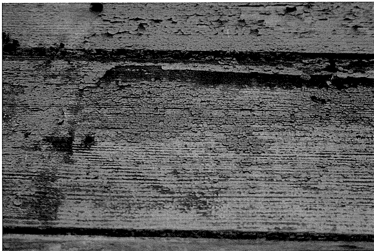
ZDJ. 12 GIŻYCKO, TWIERDZA BOYEN, BUDYNEK ĆWICZEŃ ELEWACJA PŁN-WSCH. WROTA. WIDOCZNE TRZY WARSTWY FARB W TYM NAJSTARSZA W KOLORZE UGROWYM
