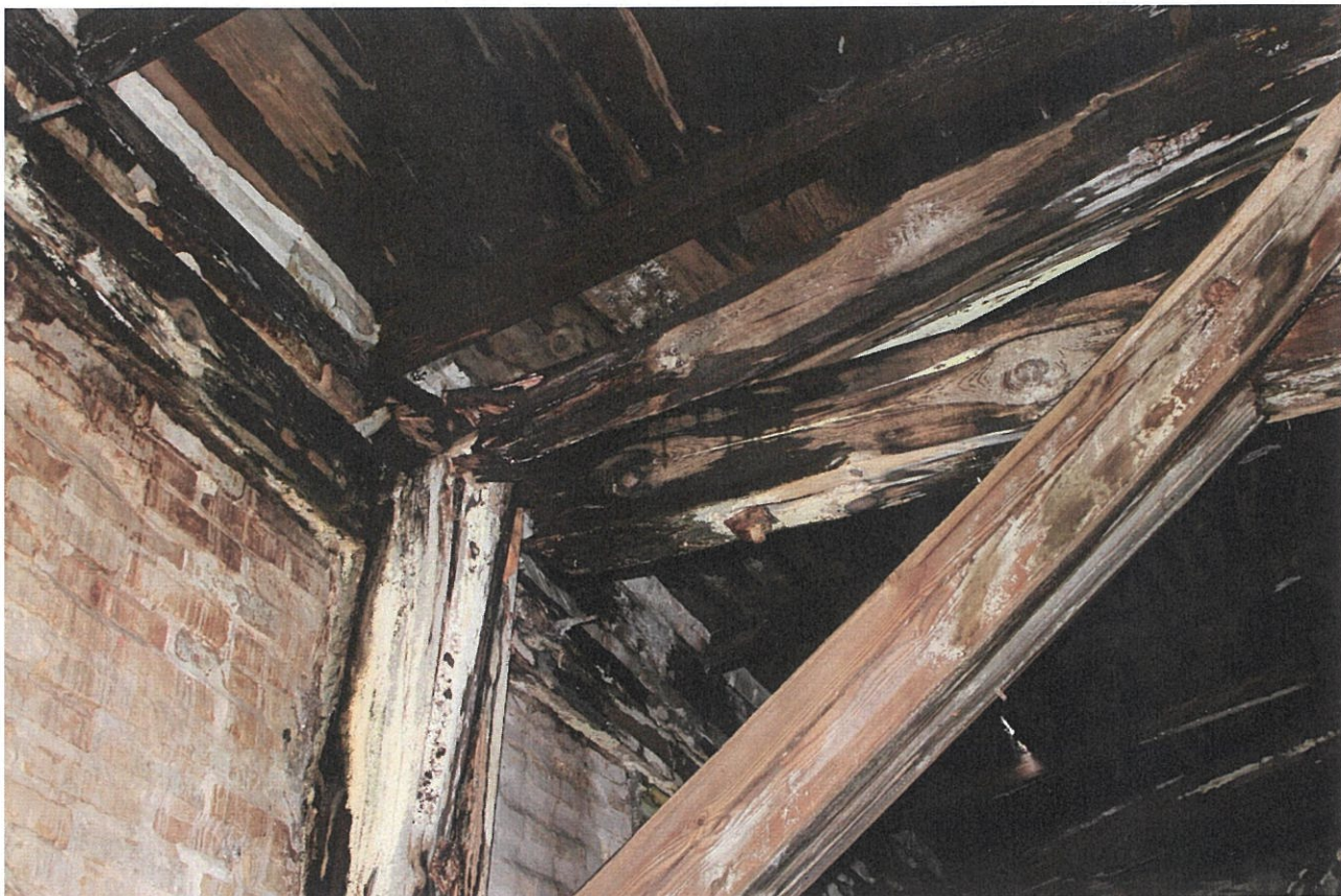
ZDJ. 32 GIŻYCKO, TWIERDZA BOYEN, BUDYNEK ĆWICZEŃ. WNĘTRZE. NIESZCZELNY DACH SPOWODOWAŁ ZAMAKANIE WIĘŻBY, KTÓRA ULEGA ROZKŁADOWI BRUNATNEMU
