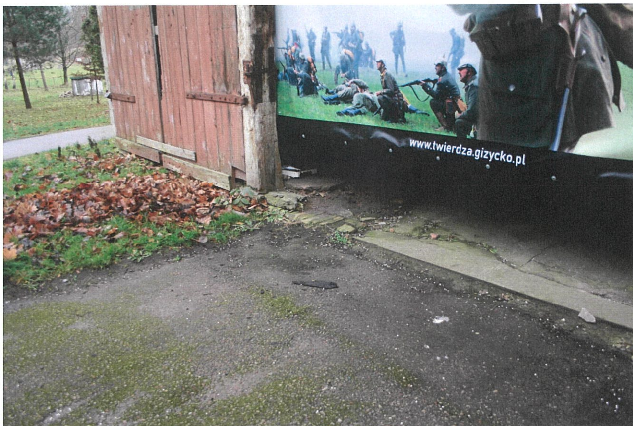
ZDJ. 9 GIŻYCKO, TWIERDZA BOYEN, BUDYNEK ĆWICZEŃ ELEWACJA PŁN-ZACH. PRÓG BETONOWY I RESZTKI PODWAŁINY NA CEGLANYM COKOLE
