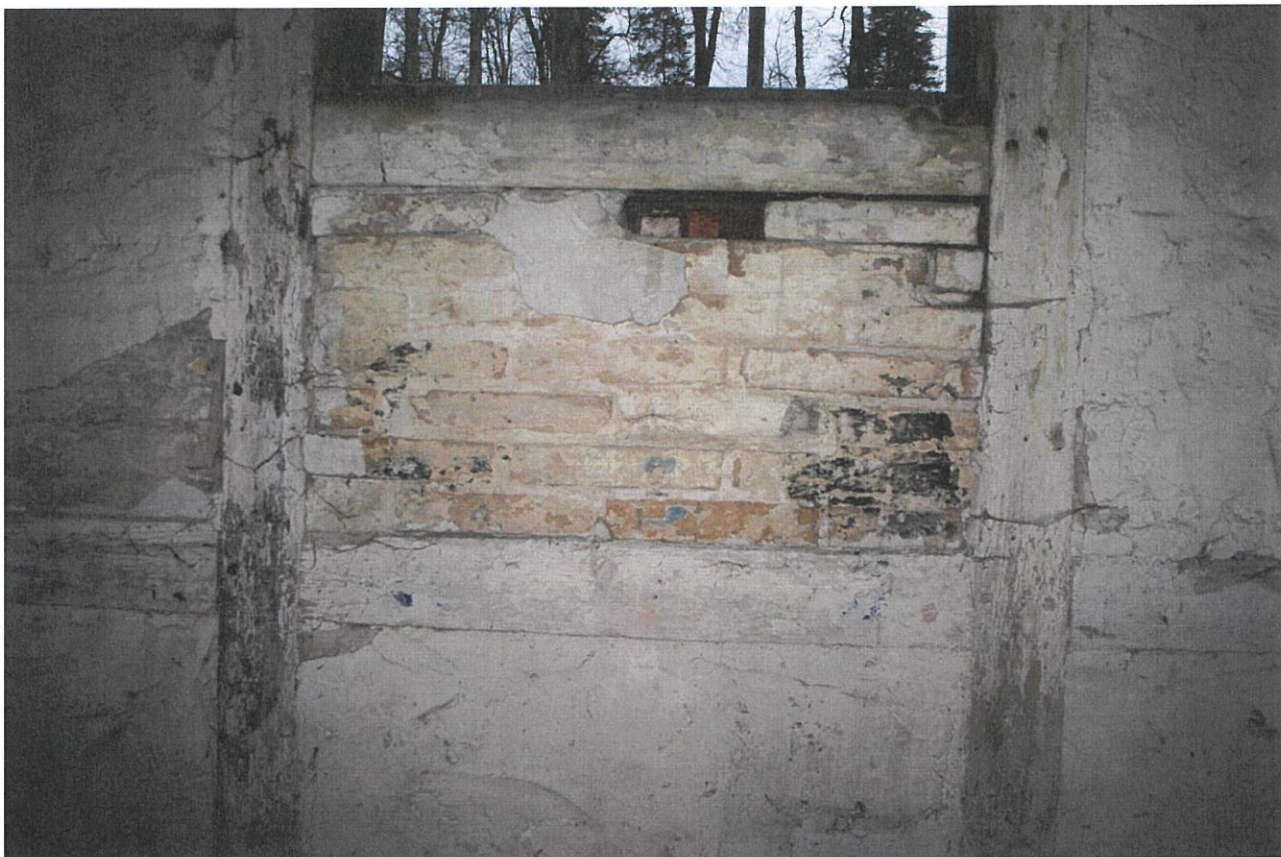
ZDJ. 13 GIŻYCKO, TWIERDZA BOYEN, BUDYNEK ĆWICZEŃ. WNĘTRZE. WIDOCZNA POBIAŁA NA POWIERZCHNIACH CEGLANYCH I DREWNIANYCH ZE ŚLADAMI POLICHROMII. NA POBIALE RESZTKI TYNKU
