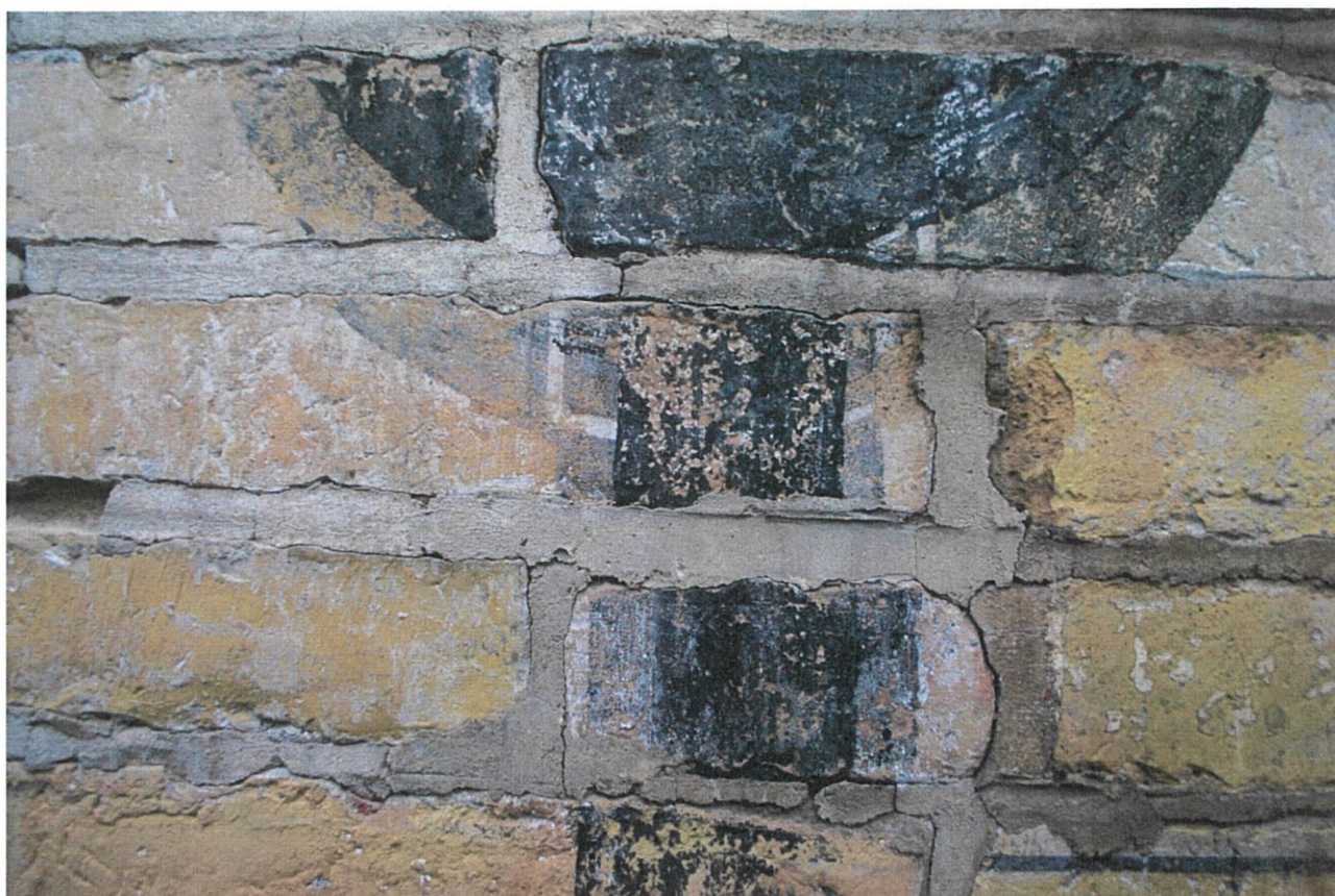
ZDJ. 24 GIŻYCKO, TWIERDZA BOYEN, BUDYNEK ĆWICZEŃ. ELEWACJA PŁN-ZACH. POLICHROMIE NA POLU 26A ZBLIŻENIE – WIDOCZNE WARSTWY PRZEMALOWAŃ
