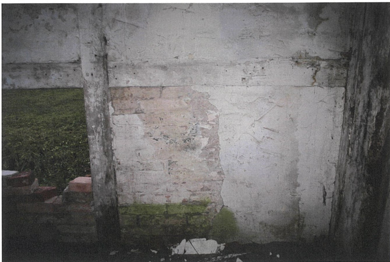
ZDJ. 37 GIŻYCKO, TWIERDZA BOYEN, BUDYNEK ĆWICZEŃ. ELEWACJA PŁD-ZACH. WYPADANIE CEGIEŁ I ROZŁUŻNIENIE KONSTRUKCJI
