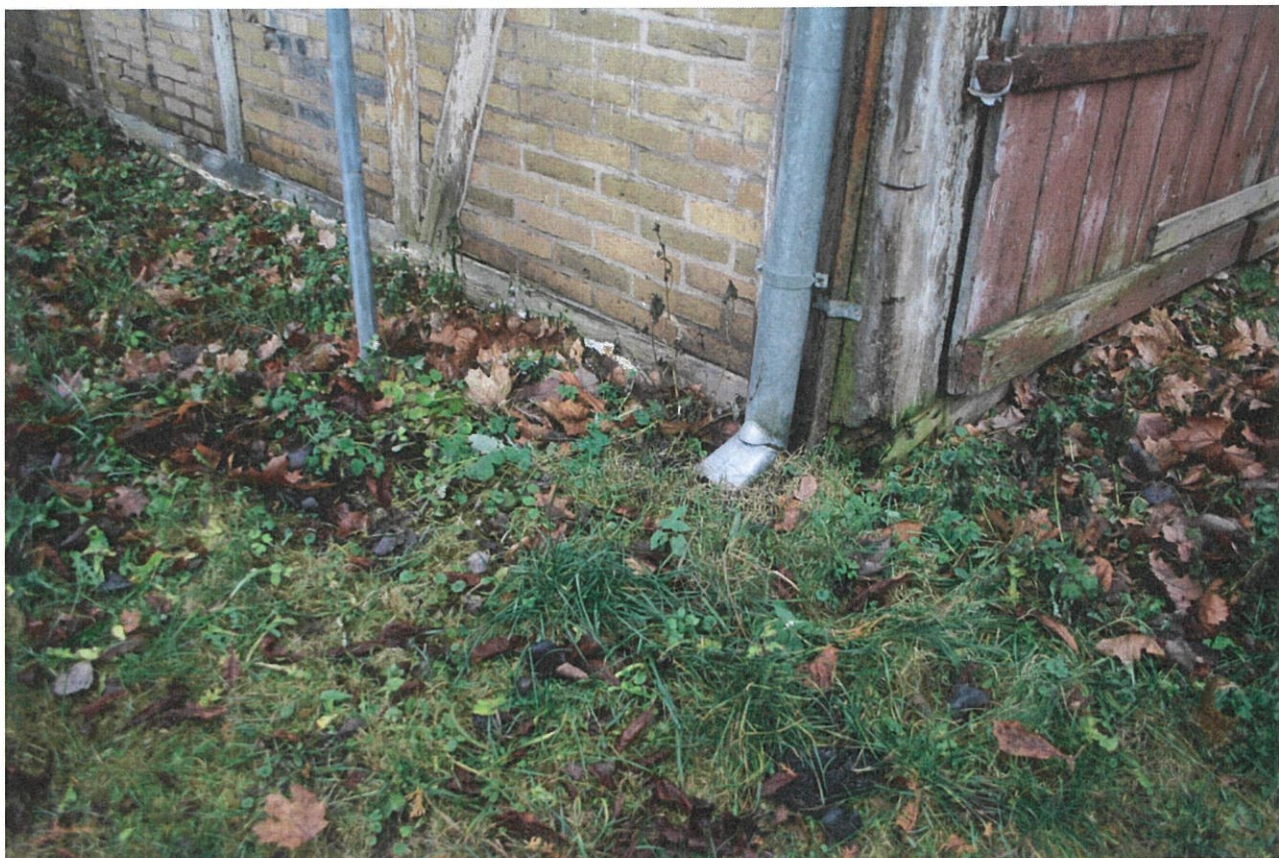
ZDJ. 34; 35 GIŻYCKO, TWIERDZA BOYEN, BUDYNEK ĆWICZEŃ. PODNIESIONY POZIOM TERENU I PODLEWANIE FUNDAMENTÓW WODĄ Z RUR SPUSTOWYCH
