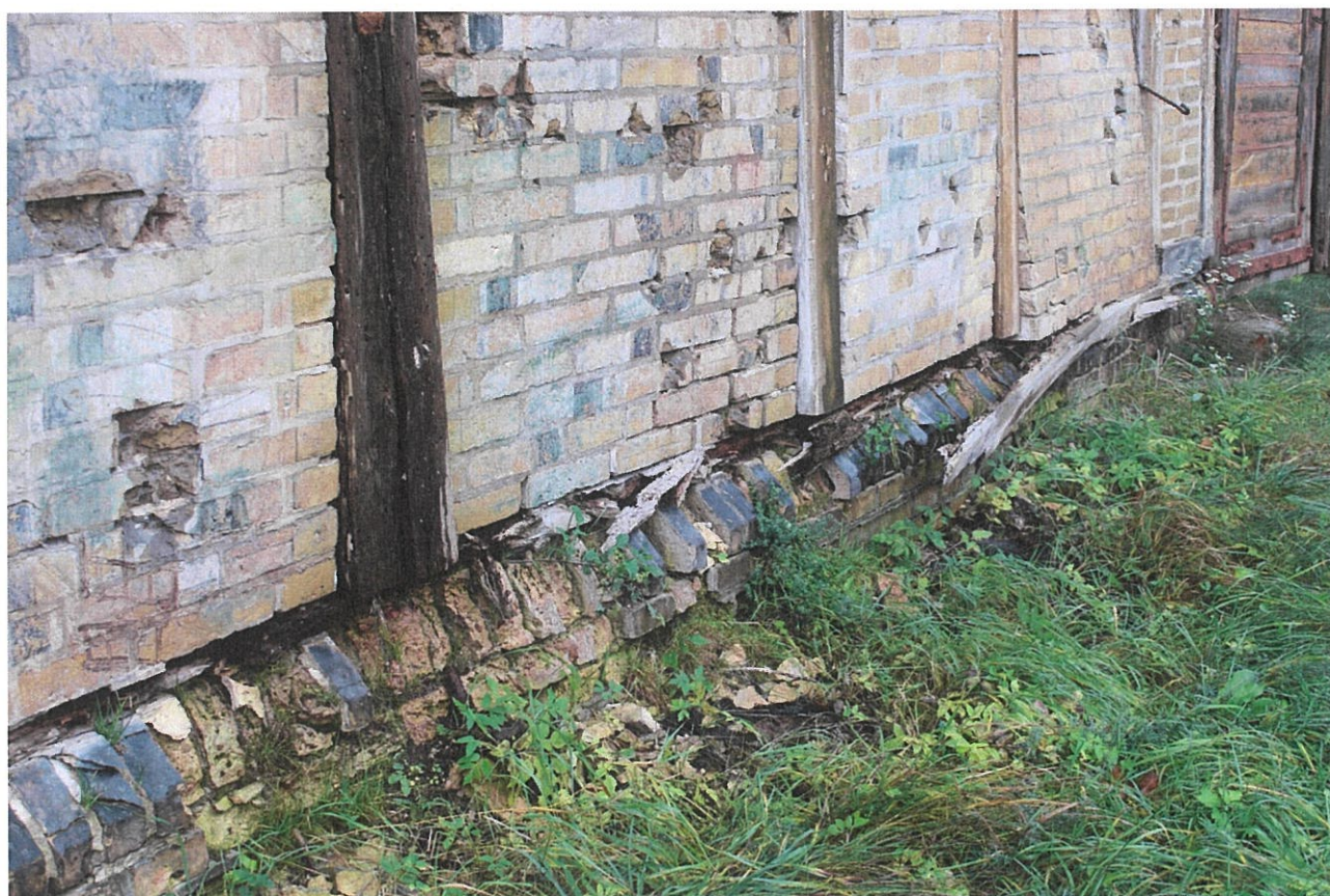
ZDJ. 31 GIŻYCKO, TWIERDZA BOYEN, BUDYNEK ĆWICZEŃ. ELEWACJA PŁN-ZACH. ZANIK PODWALINY, DESTRUKCJA CEGIEŁ COKOŁU
