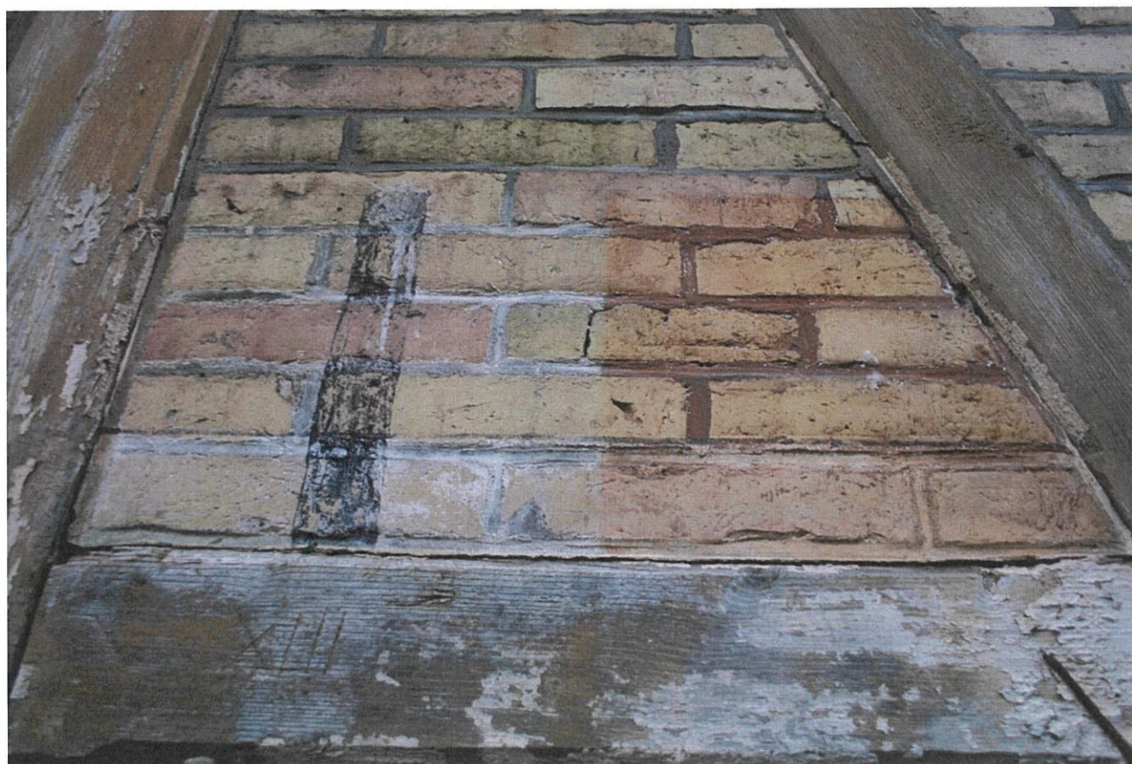
ZDJ. 10 GIŻYCKO, TWIERDZA BOYEN, BUDYNEK ĆWICZEŃ ELEWACJA PŁN-WSCH. ZNAKI MONTAŻOWE NA RYGLU
