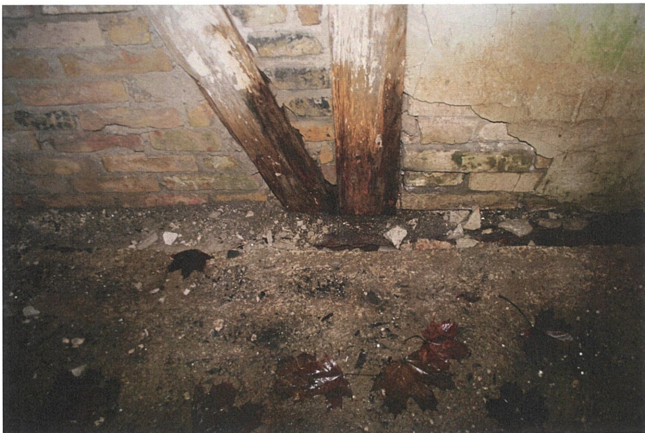
ZDJ. 33 GIŻYCKO, TWIERDZA BOYEN, BUDYNEK ĆWICZEŃ. WNĘTRZE. PODWALINA PRZESŁONIĘTA ZOSTAŁA PRZEZ BETONOWĄ WYLEWKĘ
