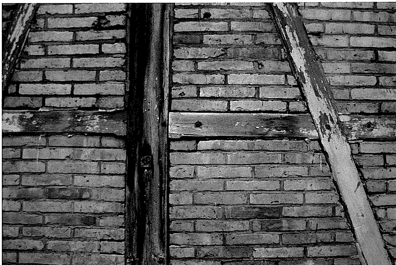
ZDJ. 5 GIŻYCKO, TWIERDZA BOYEN, BUDYNEK ĆWICZEŃ ELEWACJA PŁD-ZACH. SPOSÓB OPRACOWANIA RYGLI
