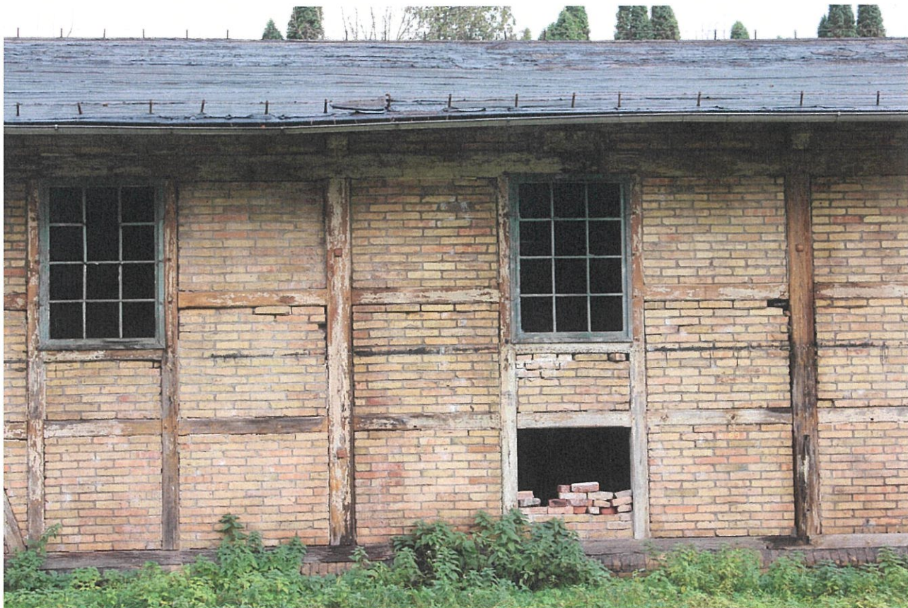
ZDJ. 37 GIŻYCKO, TWIERDZA BOYEN, BUDYNEK ĆWICZEŃ. ELEWACJA PŁD-ZACH. WYPADANIE CEGIEŁ I ROZŁUŻNIENIE KONSTRUKCJI
