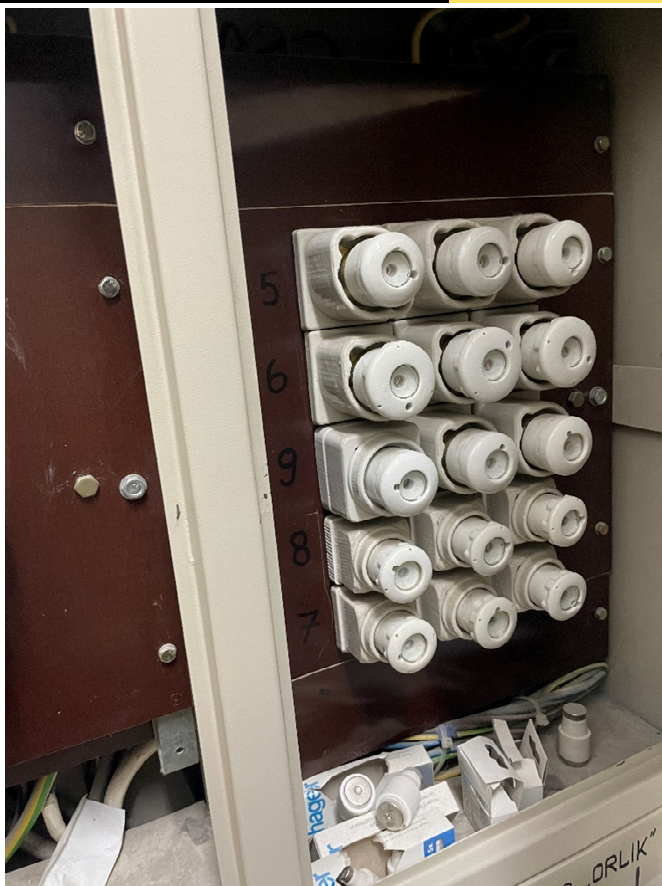
Widok na instalację elektryczną sterującą dźwigu osobowego
