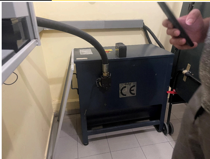
Widok na elementy elektryczne sterujące dźwigu osobowego
