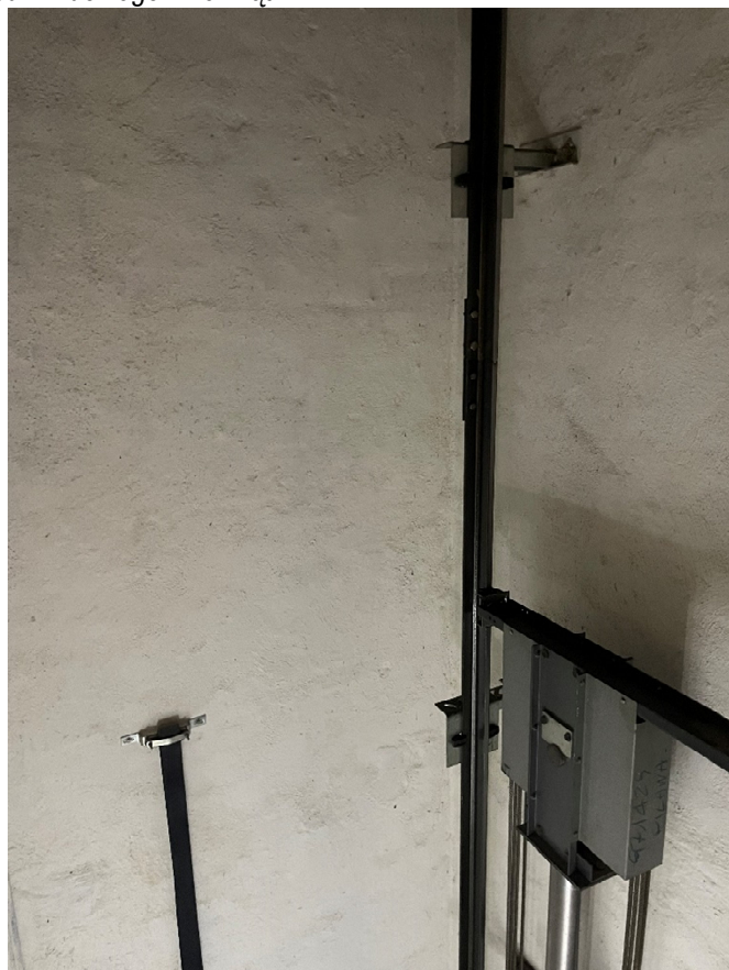
Widok na elementy konstrukcji dźwigu osobowego
