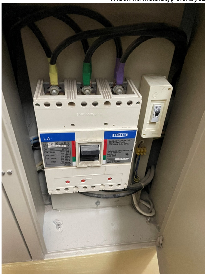
Widok na instalację elektryczną sterującą dźwigu osobowego
