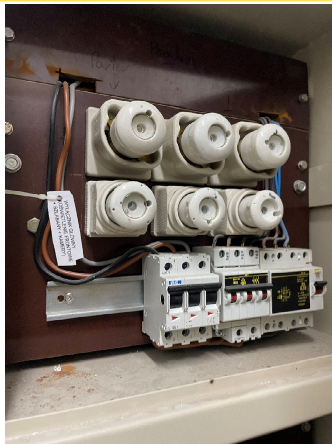
Widok na instalację elektryczną sterującą dźwigu osobowego
