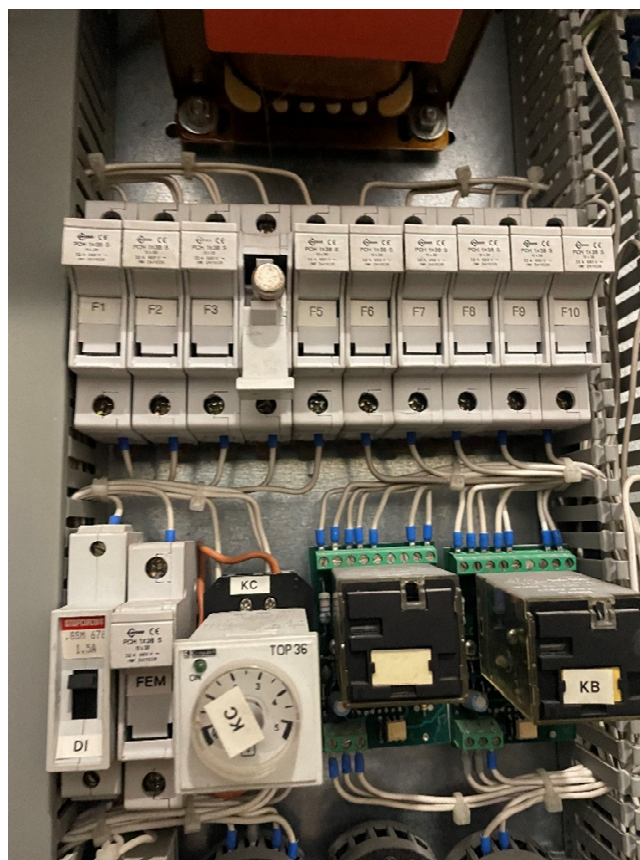
Instalacja elektryczna sterująca dźwigiem osobowym
