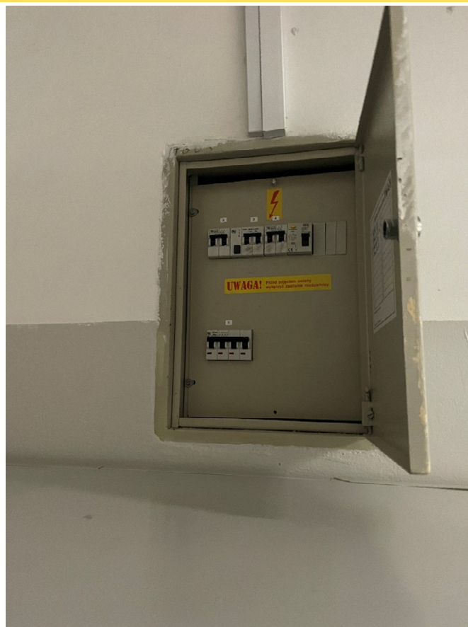
Widok na instalację elektryczną sterującą dźwigu osobowego
