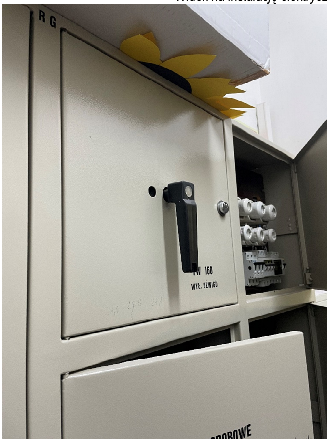
Widok na instalację elektryczną sterującą dźwigu osobowego
