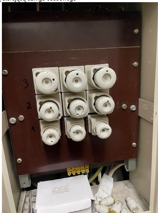
Widok na instalację elektryczną sterującą dźwigu osobowego
