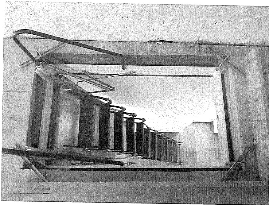
Fot. 7. Wyłaz na poddasze do czasowego demontażu
