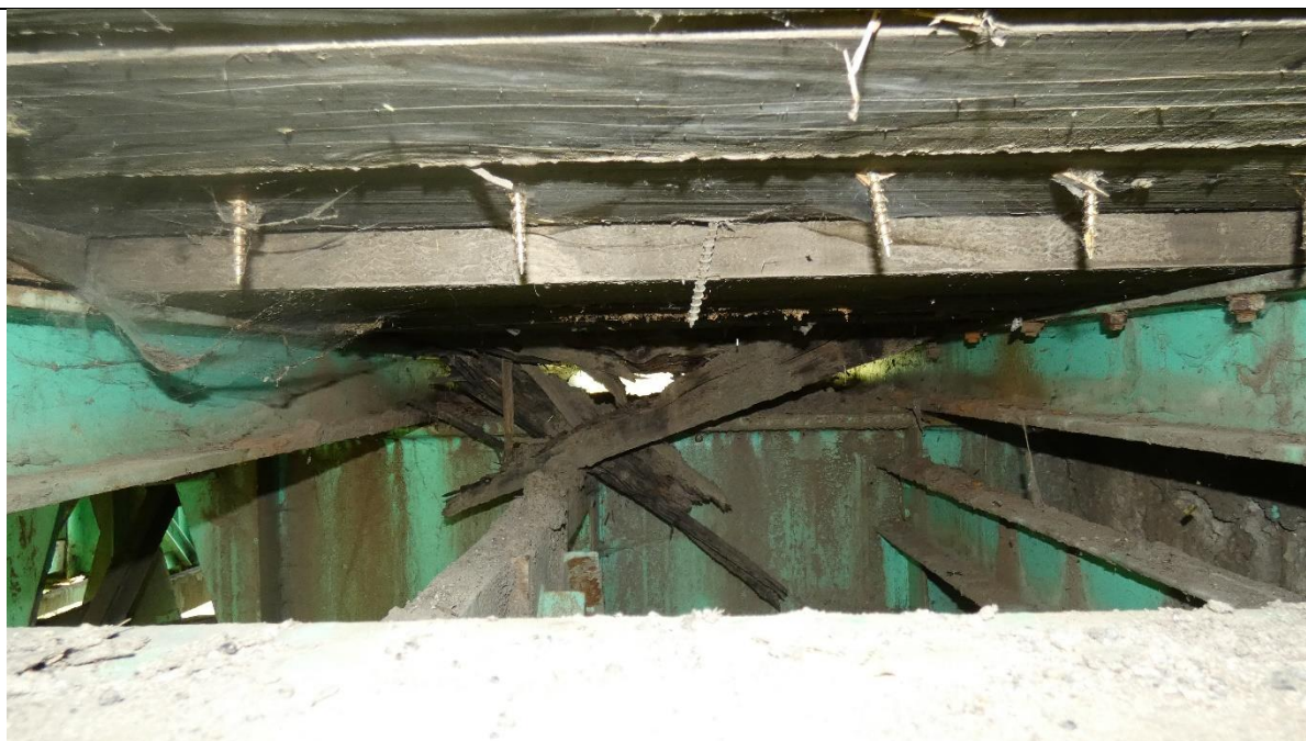
Fot. 1. zaniżenie nawierzchni obiektu, Zanieczyszczenia dyliny drewnianej (nawierzchni jezdni) na obiekcie
