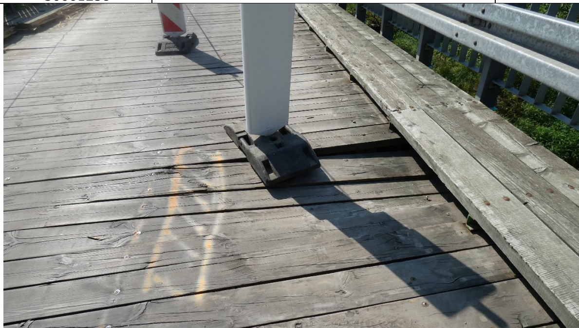
Fot. 1. zaniżenie nawierzchni obiektu, Zanieczyszczenia dyliny drewnianej (nawierzchni jezdni) na obiekcie
