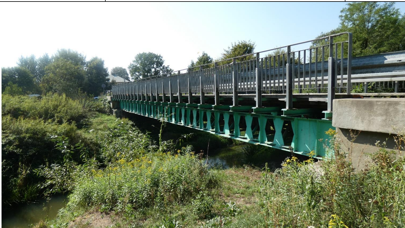
Fot. 1. Widok na obiekt
