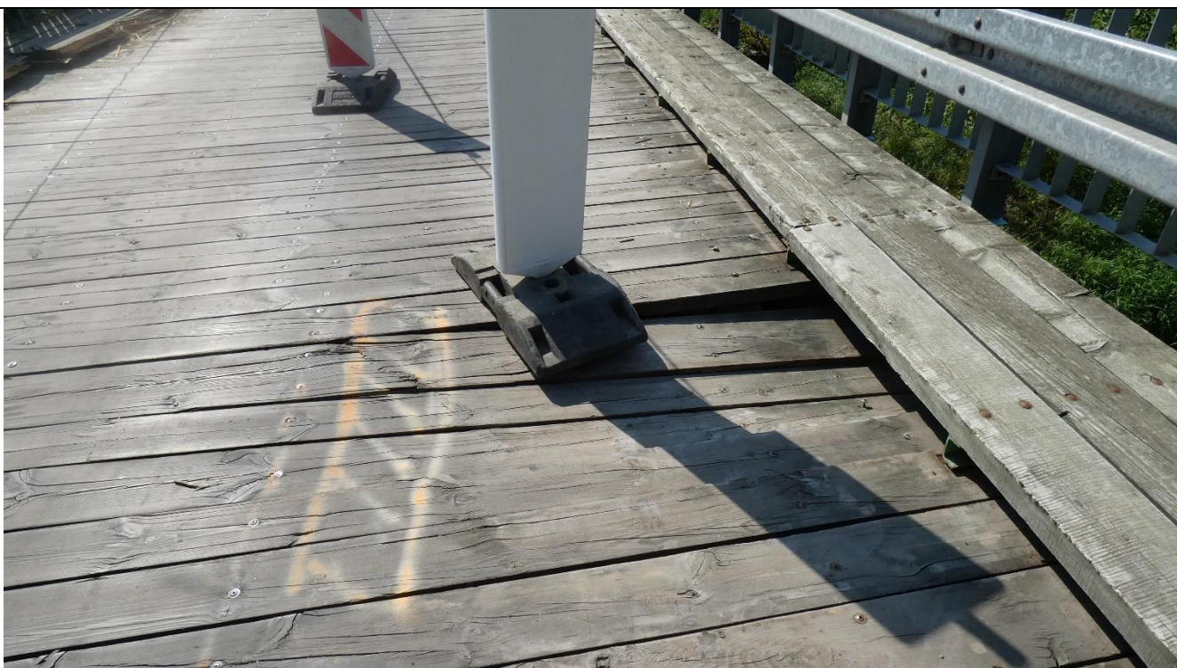
Fot. 2. Widok na nawierzchnię jezdni na obiekcie
