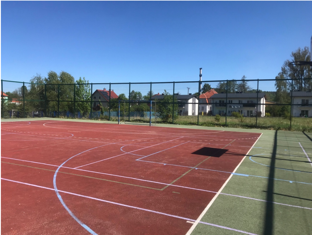
Fot. 1. Widok istniejącego boiska przed zadaszeniem
