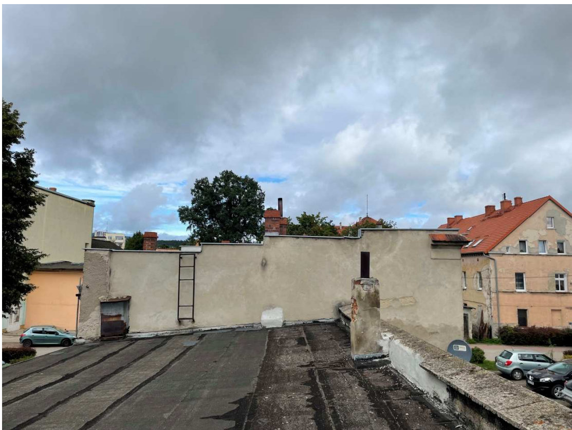
Zdj. 4 Dach kryty papą termozgrzewalną
