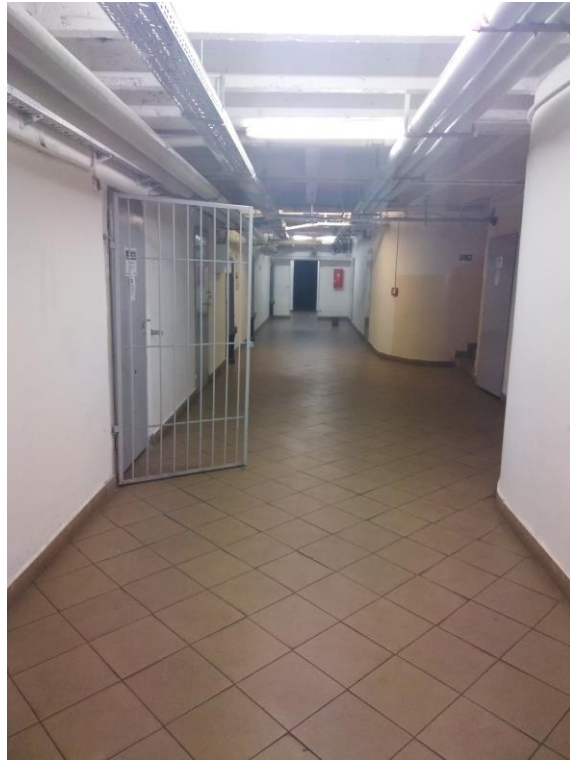
Fot. nr 3 korytarz w piwnicy
