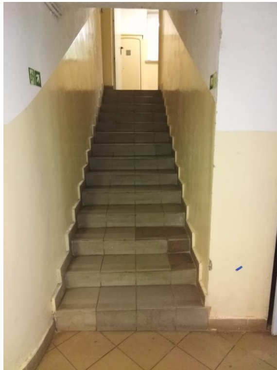
Fot. nr 4 zejście do piwnicy
