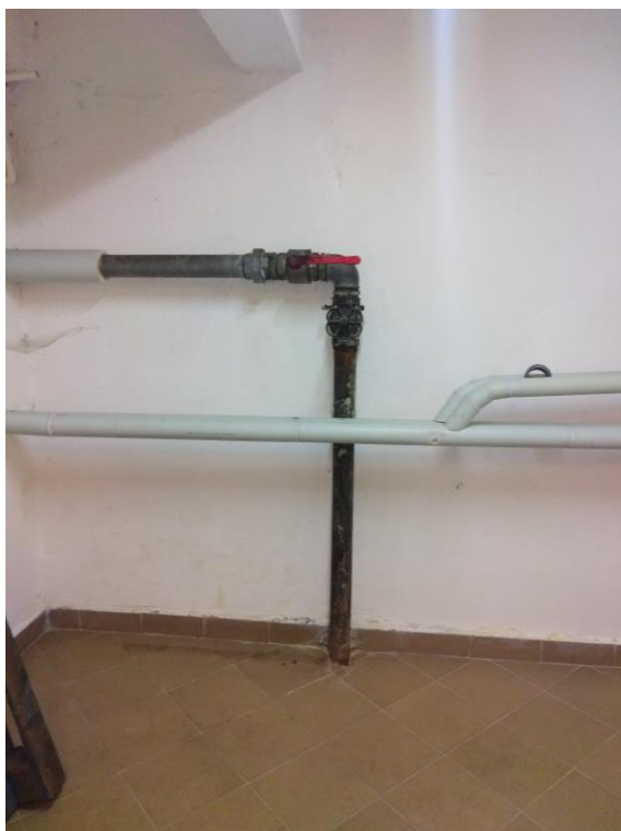
Fot. nr 8 przyłącze wodociągowe
