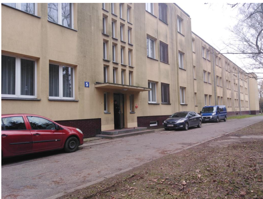
Fot. nr 2 budynek nr 5
