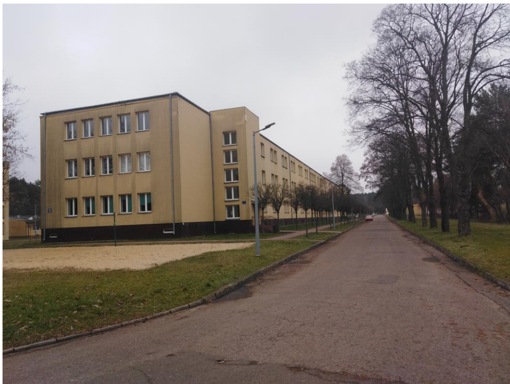
Fot. nr 1 budynek nr 5
