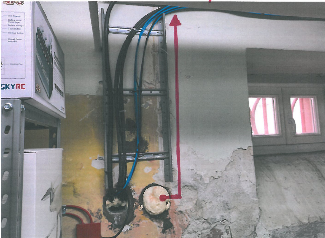
Rys. 1. Budynek 10. Miejsce wejścia do budynku nr 10 z istniejącej studni kablowej. Na fotografii czerwoną linią oznaczono istniejącą rurę przepustową, którą należy wykorzystać do wprowadzenia kabla światłowodowego i telefonicznego. Wewnątrz budynku kable układać na istniejących drabinach kablowych (na ścianie) oraz na drabinie projektowanej przytwierdzonej do stropu.
