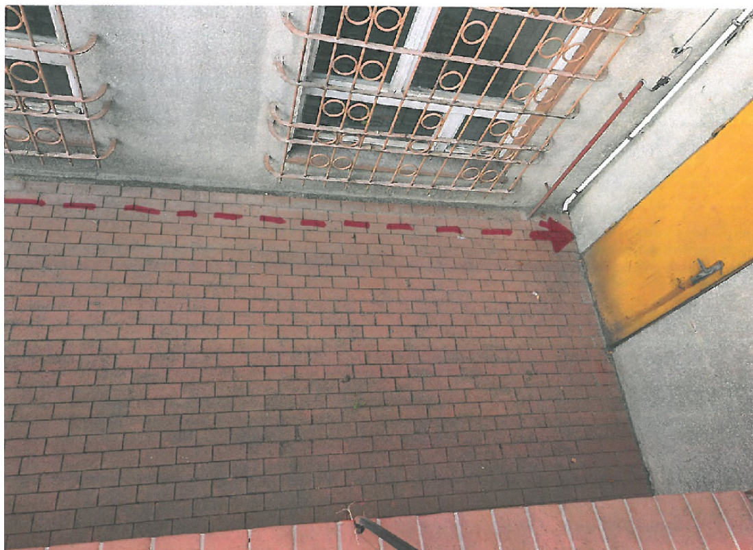
Rys. 3. Budynek 353. Czerwoną strzałką oznaczono trasę kabla układanego w istniejącej kanalizacji teletechnicznej.
