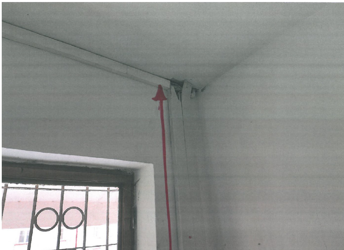
Rys. 7. Budynek 353. Czerwoną linią oznaczono trasę układania kabla.
