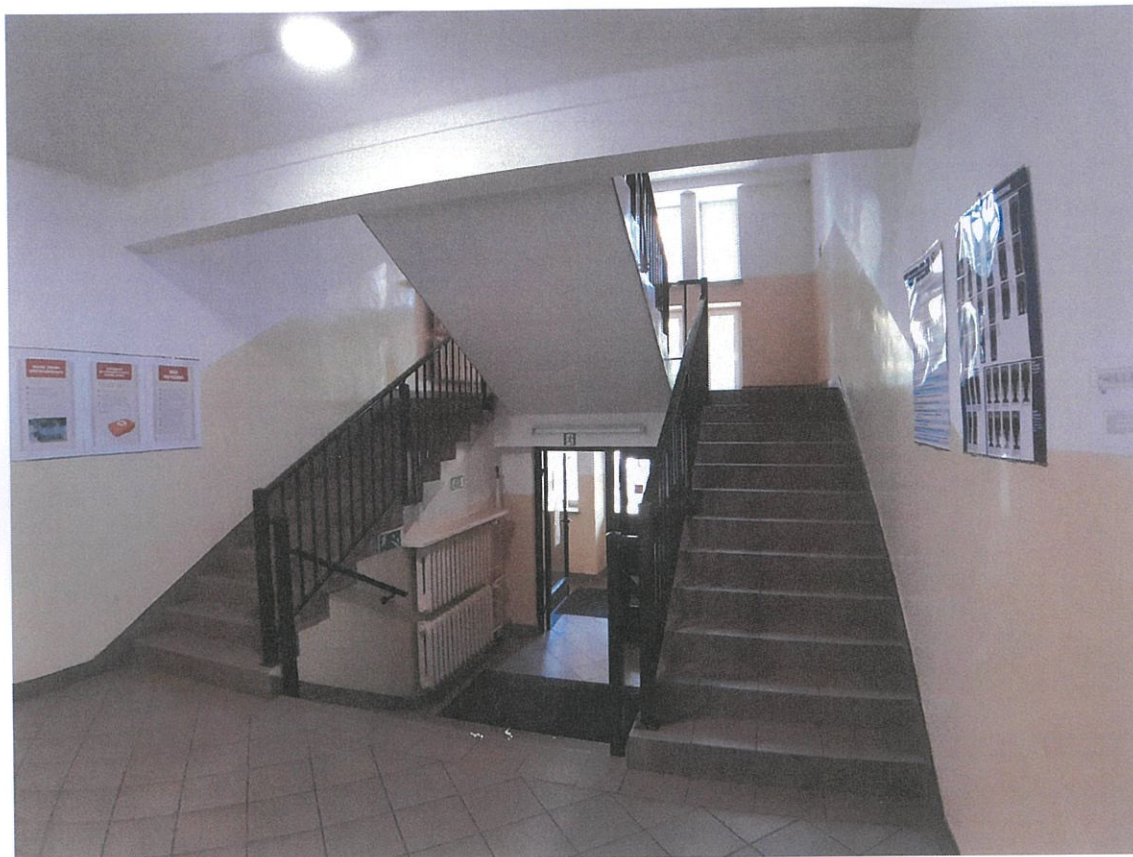
Fot. nr 7 budynek nr 5
