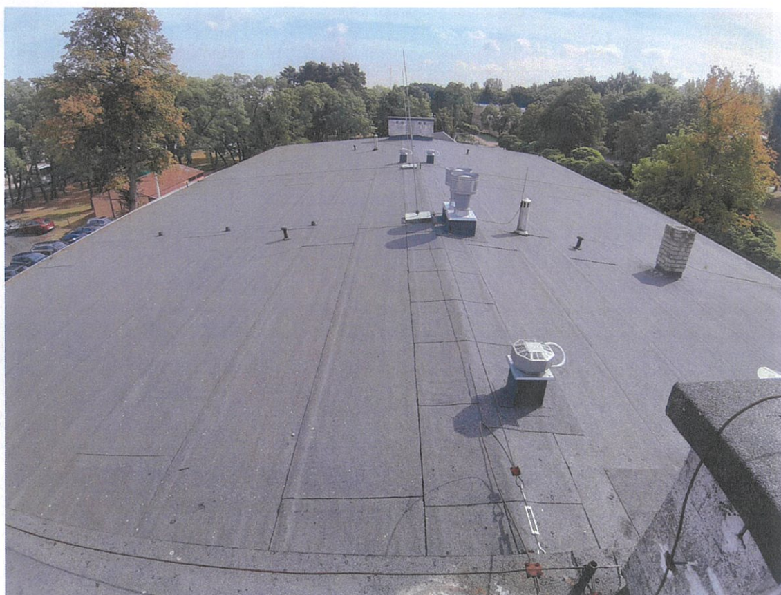
Fot. nr 10 budynku nr 12, 50 ,14
