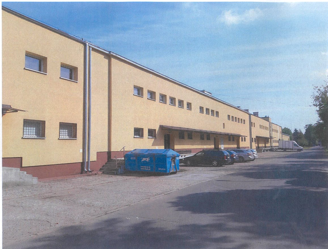
Fot. nr 9 budynku nr 12, 50 ,14
