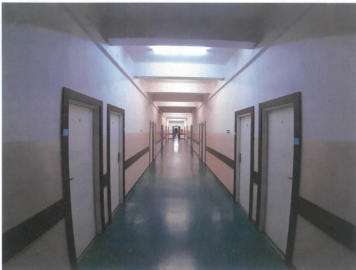
Fot. nr 6 budynek nr 5
