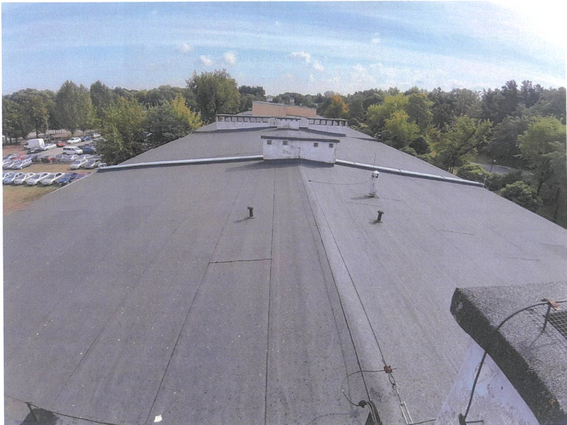
Fot. nr 14 budynki nr 12, 50 ,14
