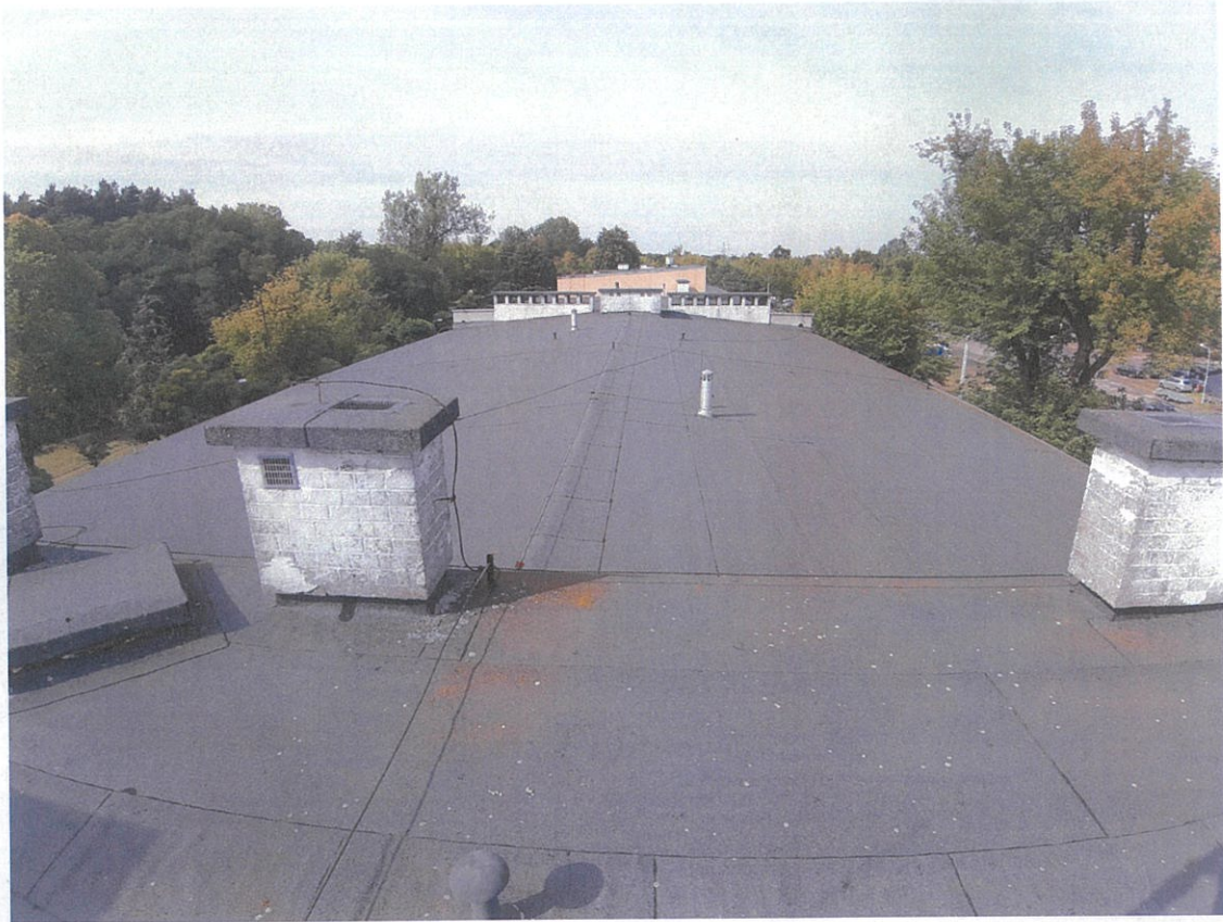
Fot. nr 11 budynku nr 12, 50 ,14
