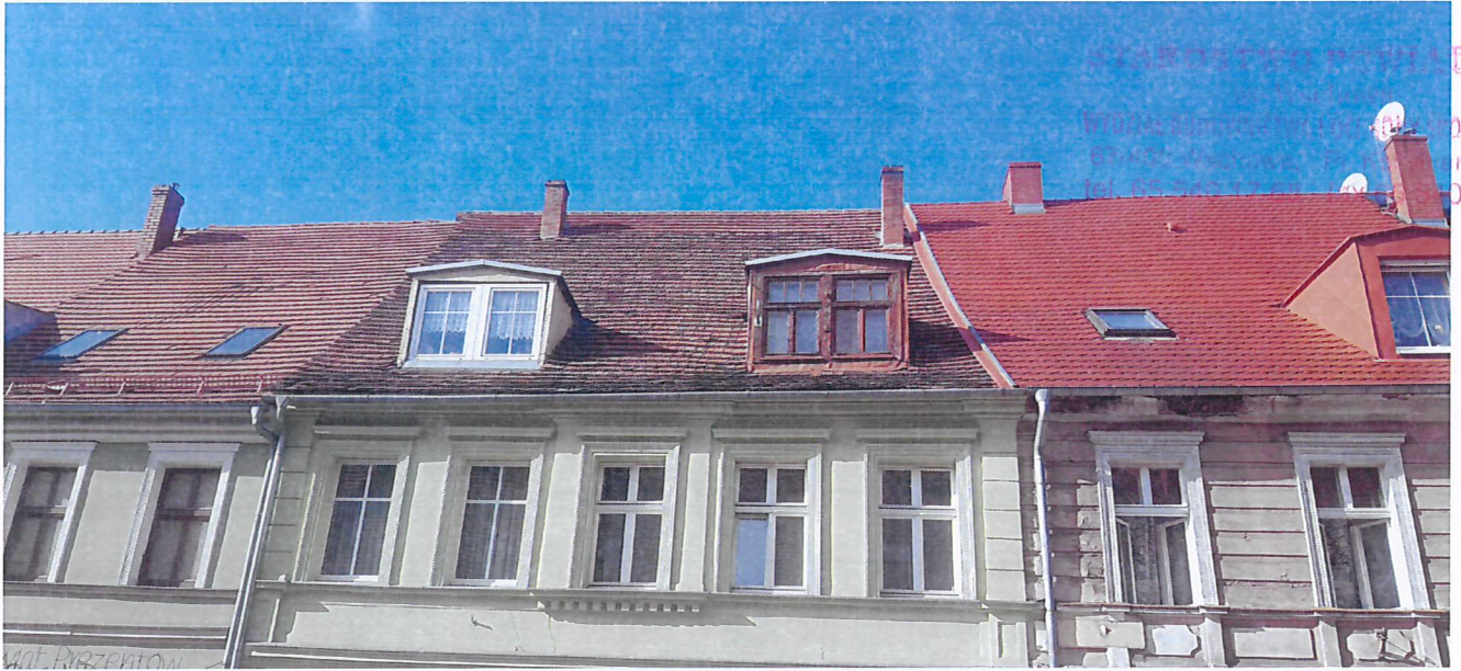
Fot. 1 Widok dachu od strony elewacji frontowej.
