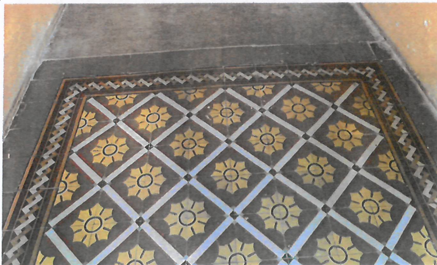
Fot. 10 Widok posadzki na parterze.
