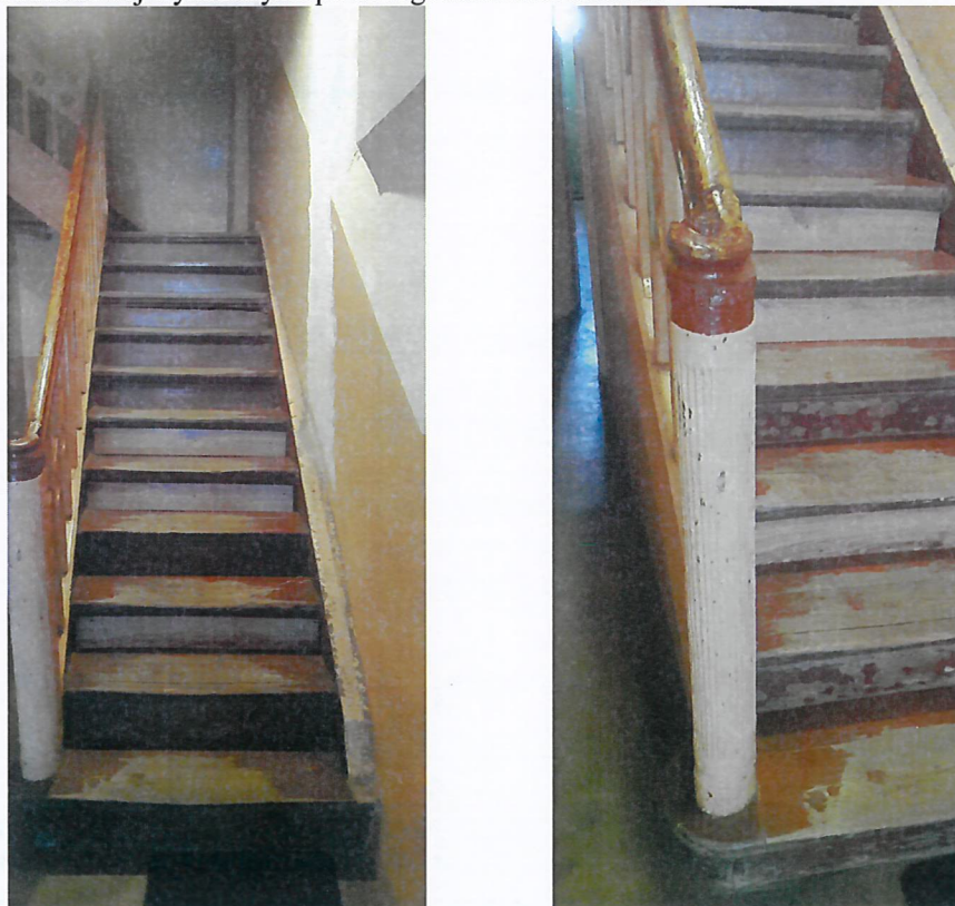
Fot. 6.7 Widok pierwszego biegu schodów.
