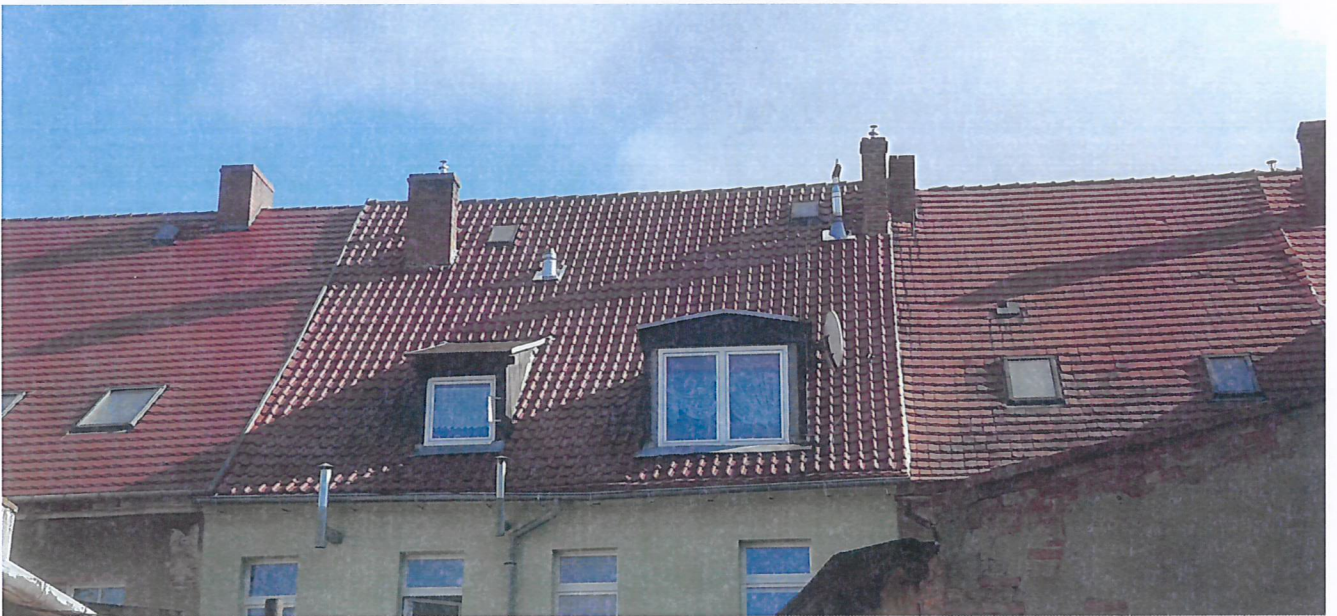
Fot. 2 Widok dachu od strony elewacji podwórzowej.
