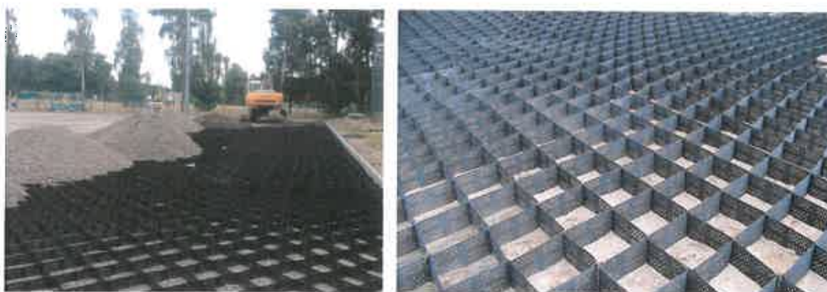
Przykładowe nawierzchnie budowane w technologii geokrat
