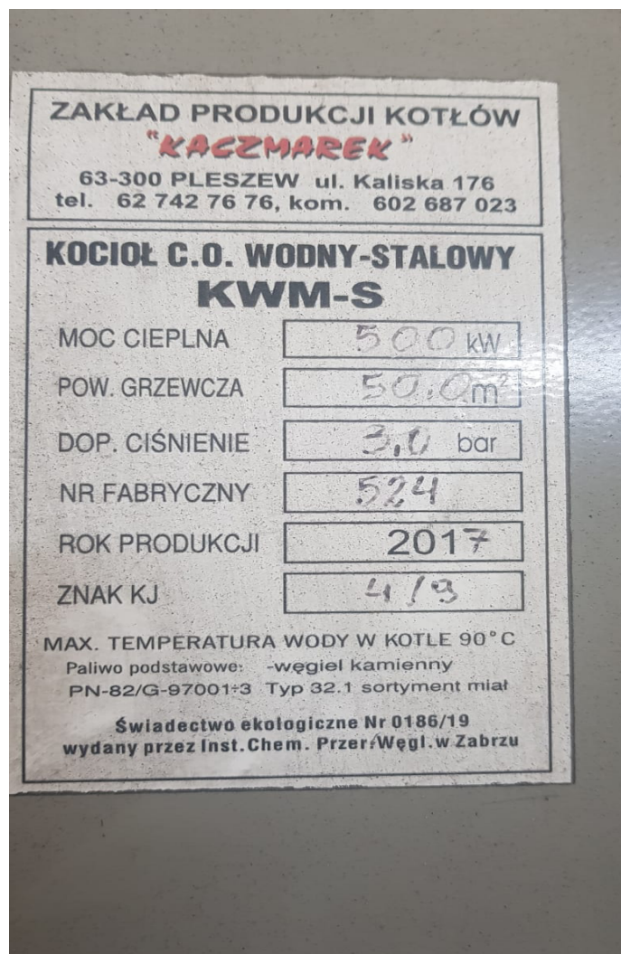
Rys. 3. Jedna z tablic znamionowych istniejących kotłów na potrzeby C.O.
