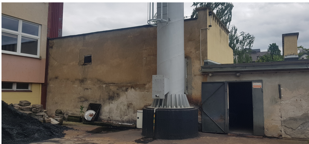
Rys. 1. Budynek modernizowanej kotłowni wraz z istniejącym kominem
