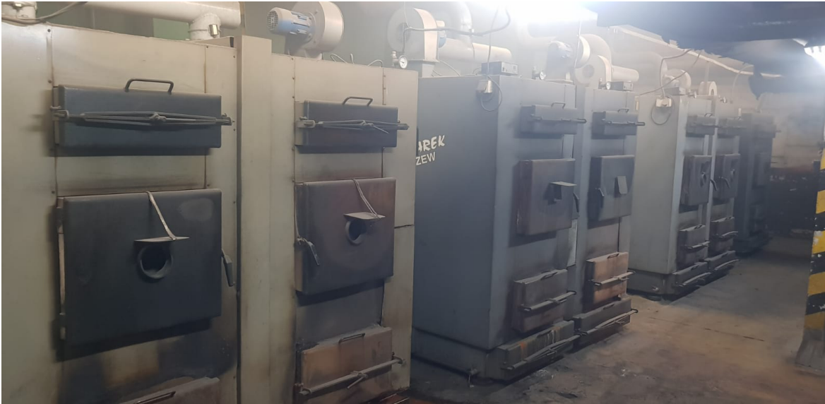
Rys. 2. Istniejące kotły wodne miałowe przeznaczone do demontażu
