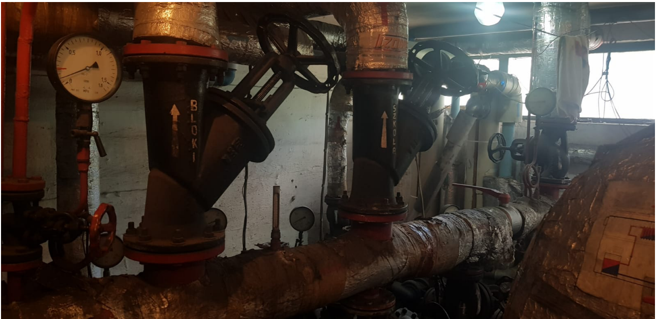
Rys. 5. Istniejący rozdzielacz
