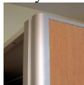
Rys. 5 - Ściana czołowa z panelem z płyty monoform.
