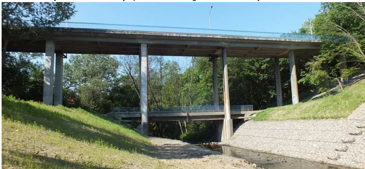
Rys. 1.2 Widok na obiekt od strony wody górnej
