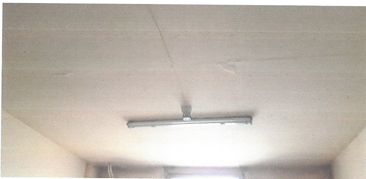
Rys. 7 Widok na sufit podwieszany
