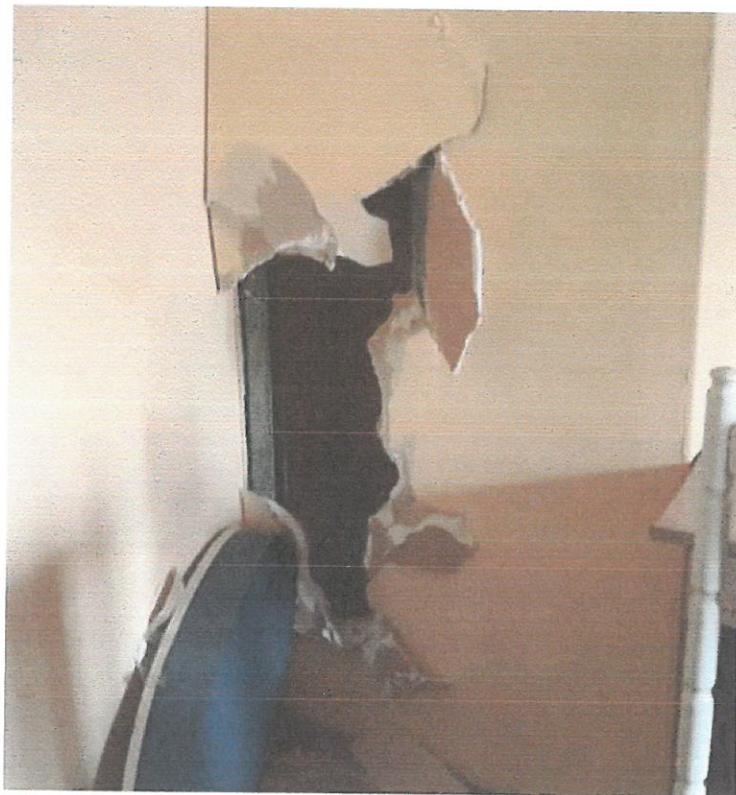
Rys. 4 Widok na obudowę słupa nośnego
