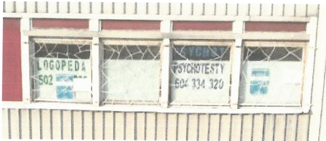
Rys. 8 Widok na stolarkę okienną od zewnątrz
