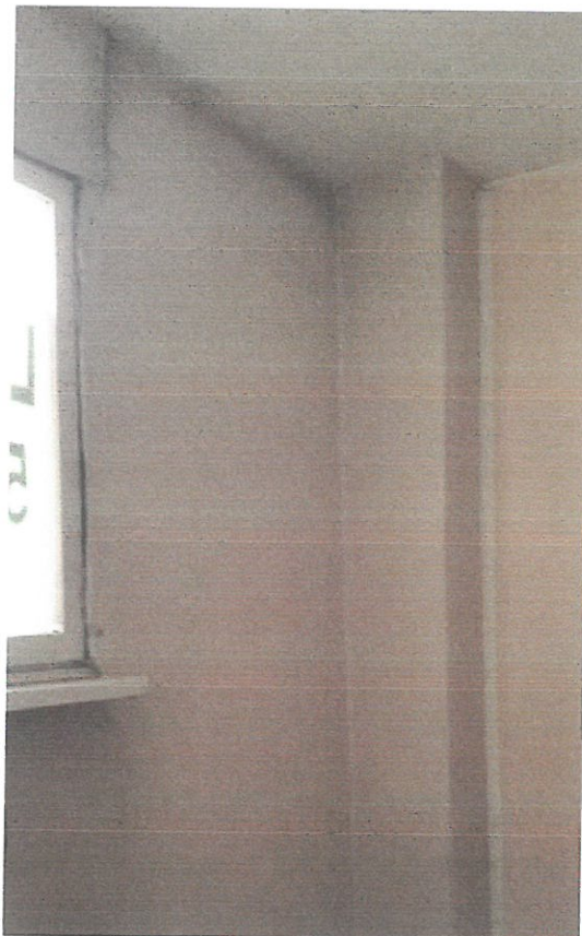
Rys. 6 Widok na obudowę ściany zewnętrznej oraz obudowę słupa nośnego
