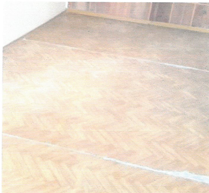
Rys. 3 Widok na posadzkę w pomieszczeniu oznaczonym jako M1N
