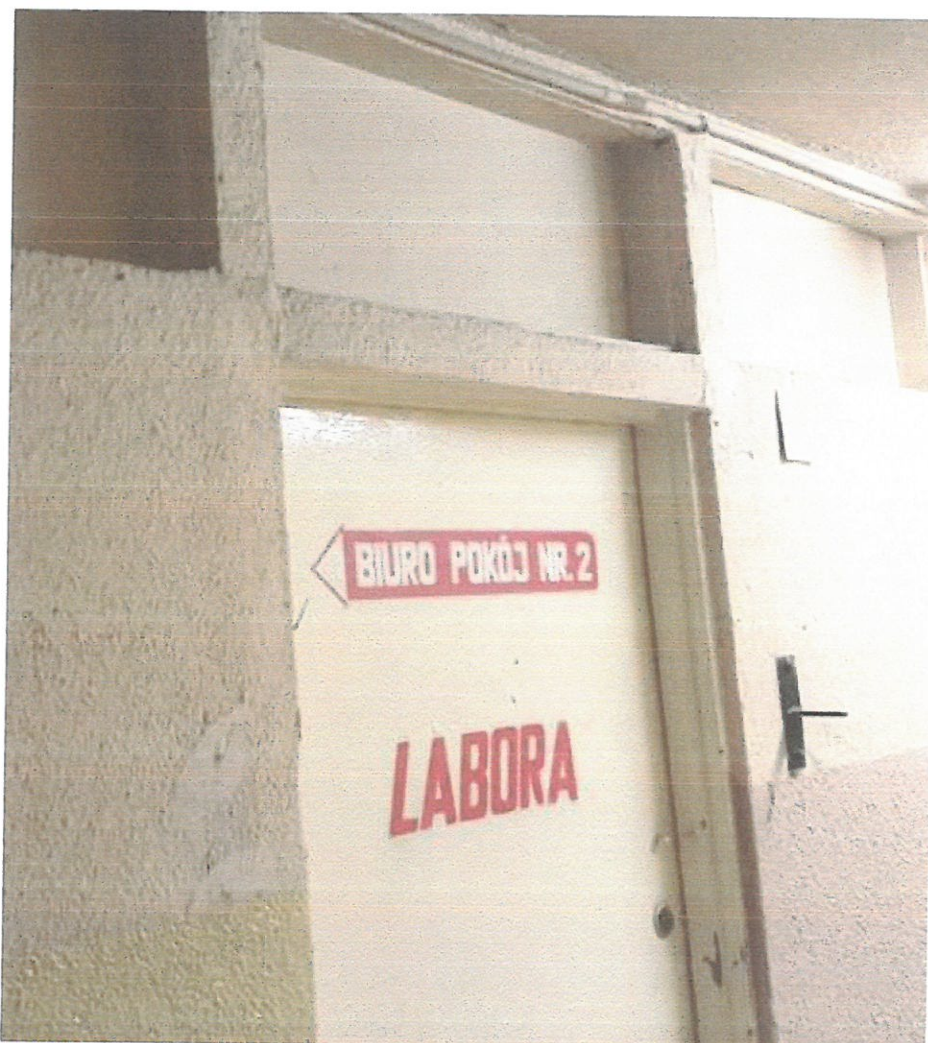
Rys. 10 Widok na stolarkę drzwiową
