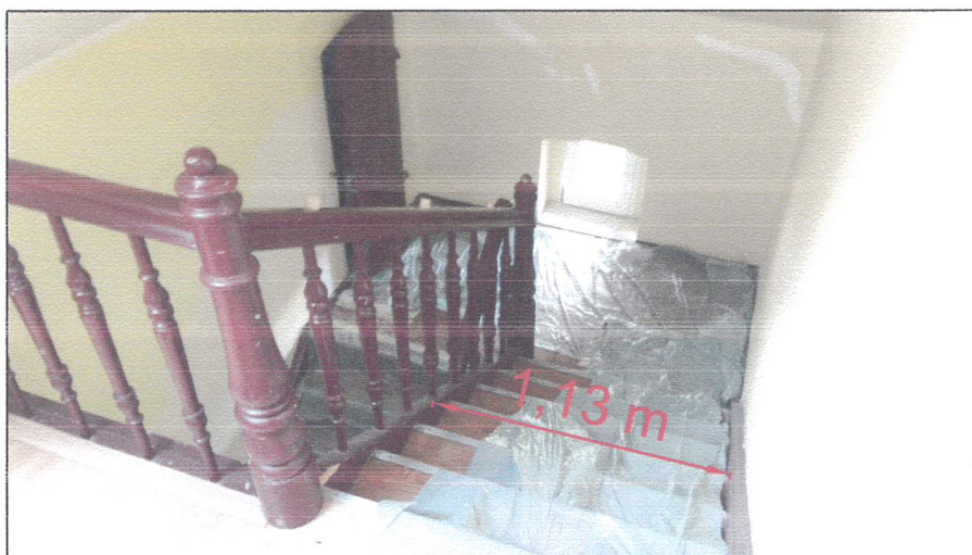
Fot. nr 5 - Widok klatki schodowej K2
