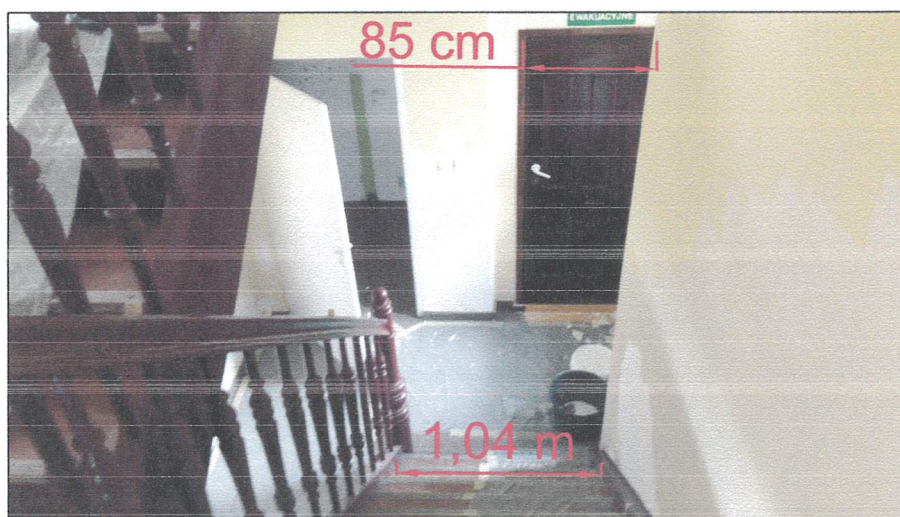
Fot. nr 6 - Widok drzwi Dw2
