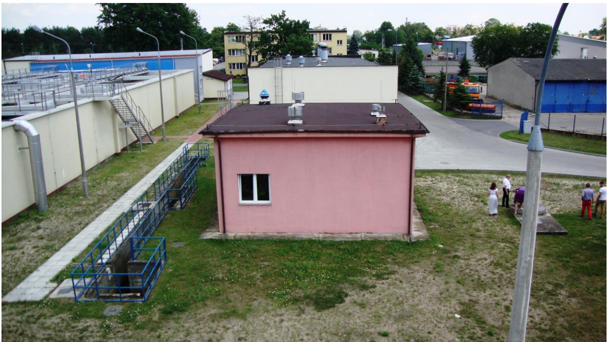
Fot. nr 3 – Pompownia Miejska – elewacja zach.
