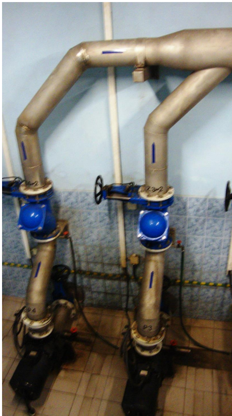
Fot. nr 7 – Pompownia Miejska –kondygnacja podziemna – 2 (103,55), studni komory suchej - pomp
