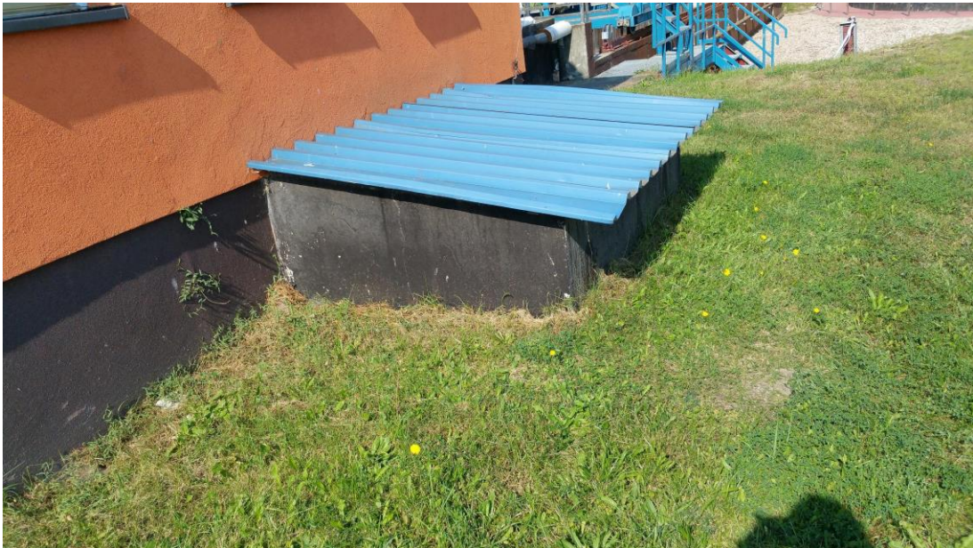
Fot. Nr10 – Budynek krat Ob. nr 3 – elewacja wsch.
