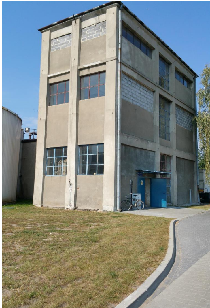
Fot. nr18 – Budynek obsługi OB.24
