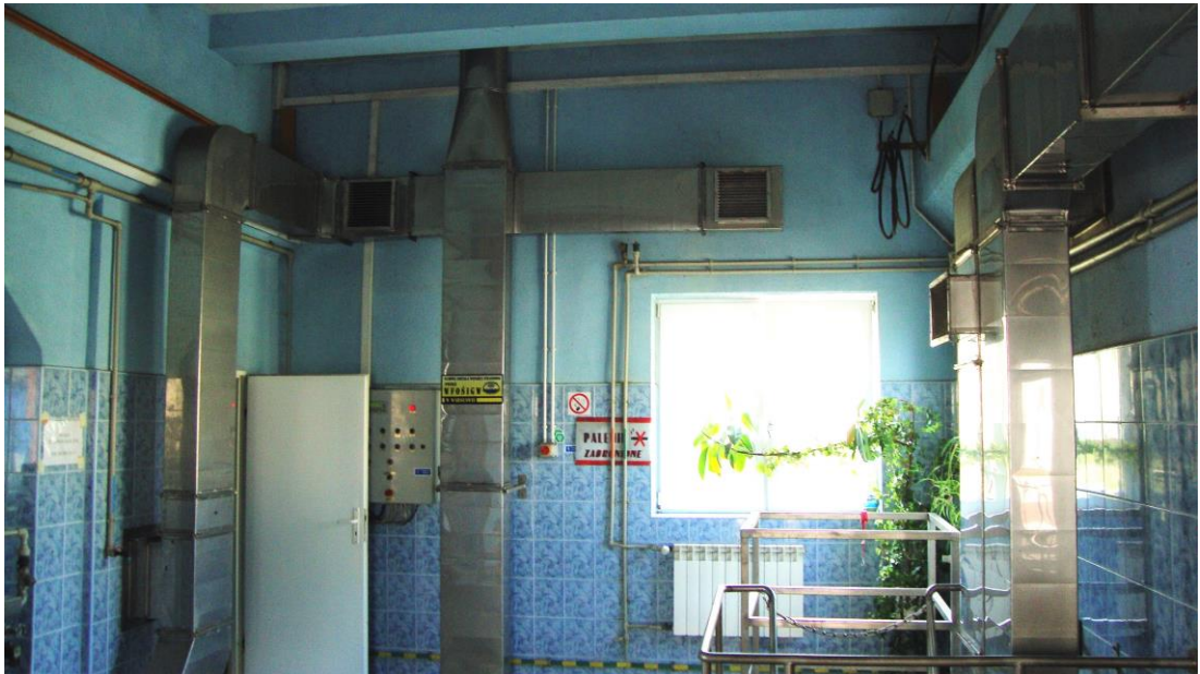
Fot. nr 5 – Pompownia Miejska – hala kraty kondygnacja nadziemna.
