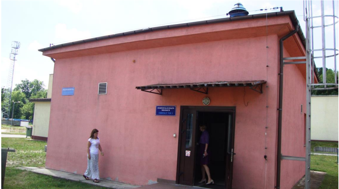
Fot. nr 4 – Pompownia Miejska – elewacja wsch.
