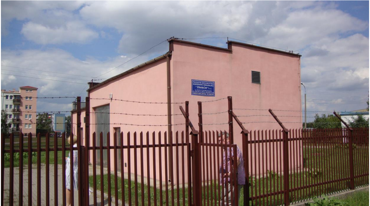
Fot. Nr31 – Budynek Pompowni Gdańska elewacja od ul. Gdańskiej
