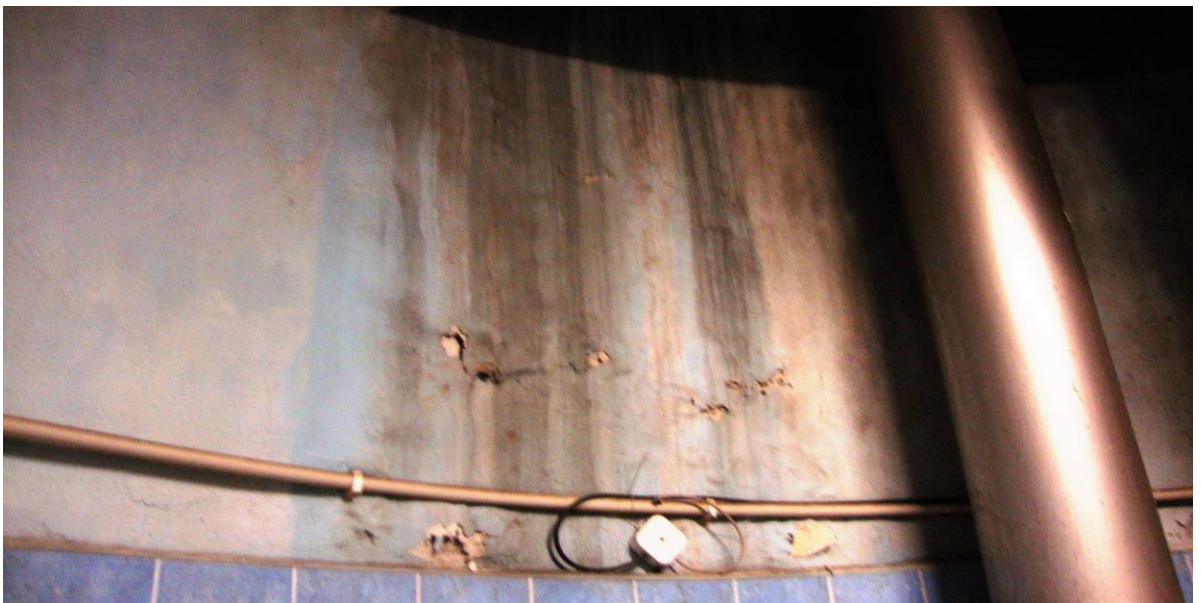
Fot. Nr34 – Budynek Pompowni –Kondygnacja podziemna - studnia
