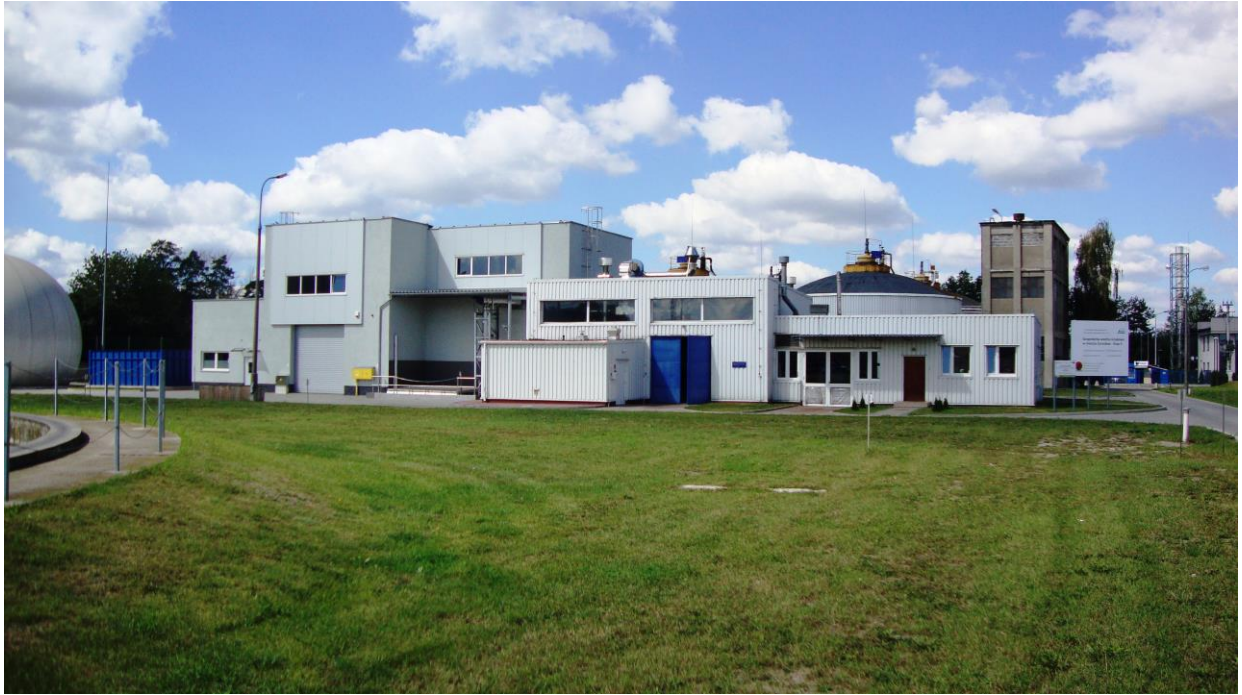
Fot. Nr23 – Budynek Ob. nr 26 z przylegającą od str. zach. Suszarnią osadu Ob. nr 27
