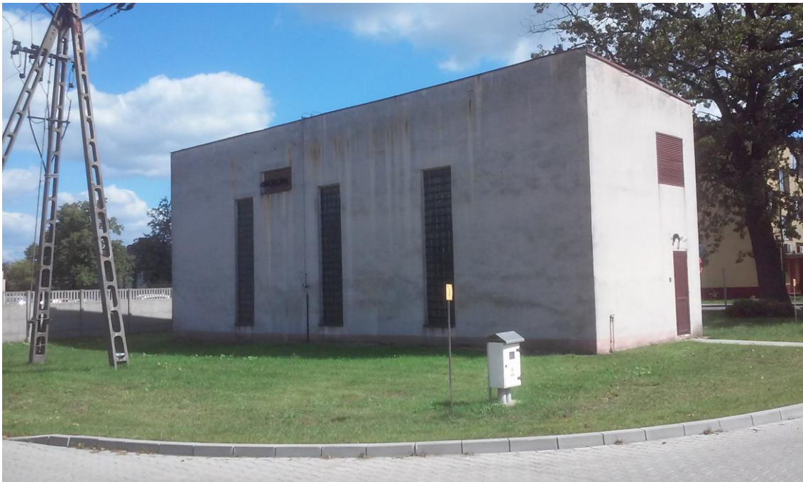
Fot. Nr27 – Budynek Rozdzielni SN elewacja płn./zach.
