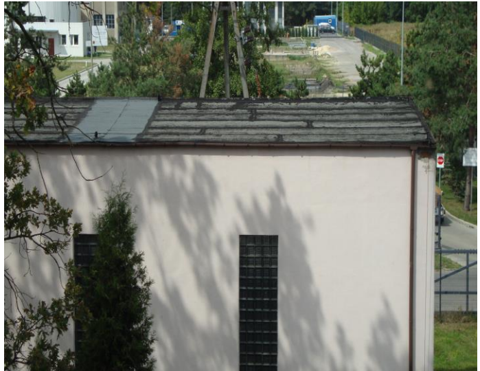
Fot. Nr30 – Budynek Rozdzielni SN dach.
