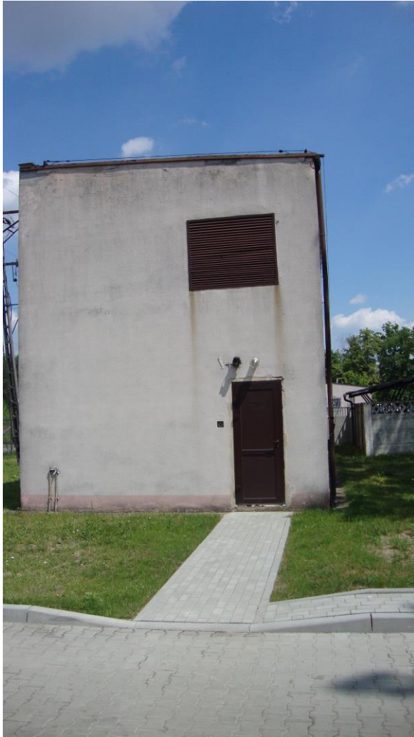
Fot. Nr29 – Budynek Rozdzielni SN elewacja wsch.
