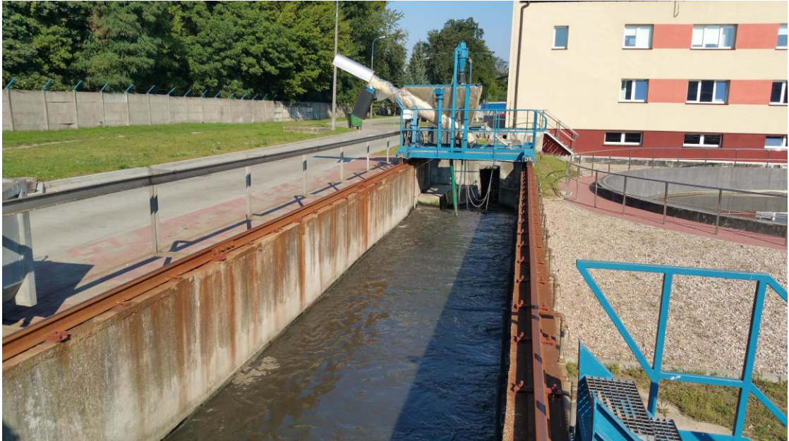
Fot. Nr12 – Piaskownik napowietrzany Ob. nr 4
