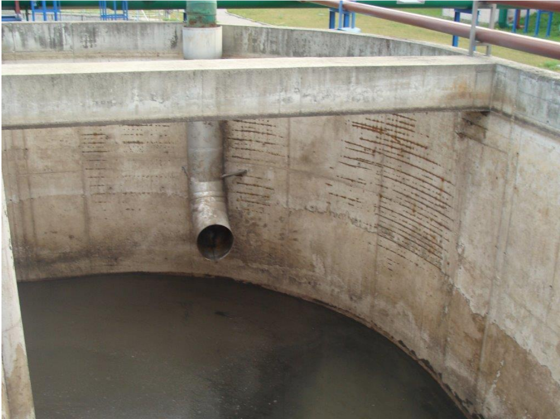
Fot. Nr13 – Zbiornik denitryfikacji OB. 9
