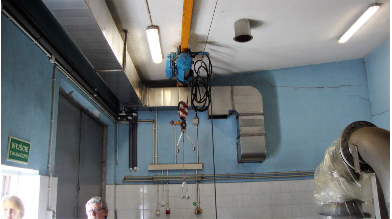
Fot. Nr33 – Budynek Pompowni – pomieszczenie szaf sterowniczych, hala kraty
