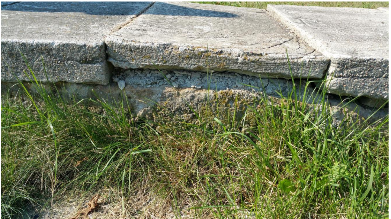
Fot. nr 1 – Kanał korytowy- dopływ z pompowni Gdańska
