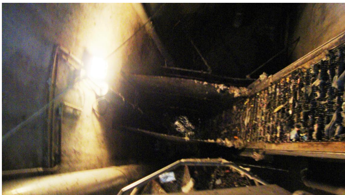
Fot. nr 7 – Pompownia Miejska – schody kondygnacji podziemnej, studni komory czerpальной i kraty
