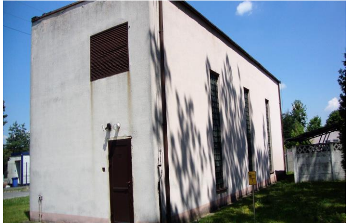
Fot. Nr28 – Budynek Rozdzielni SN elewacja płd./zach.
