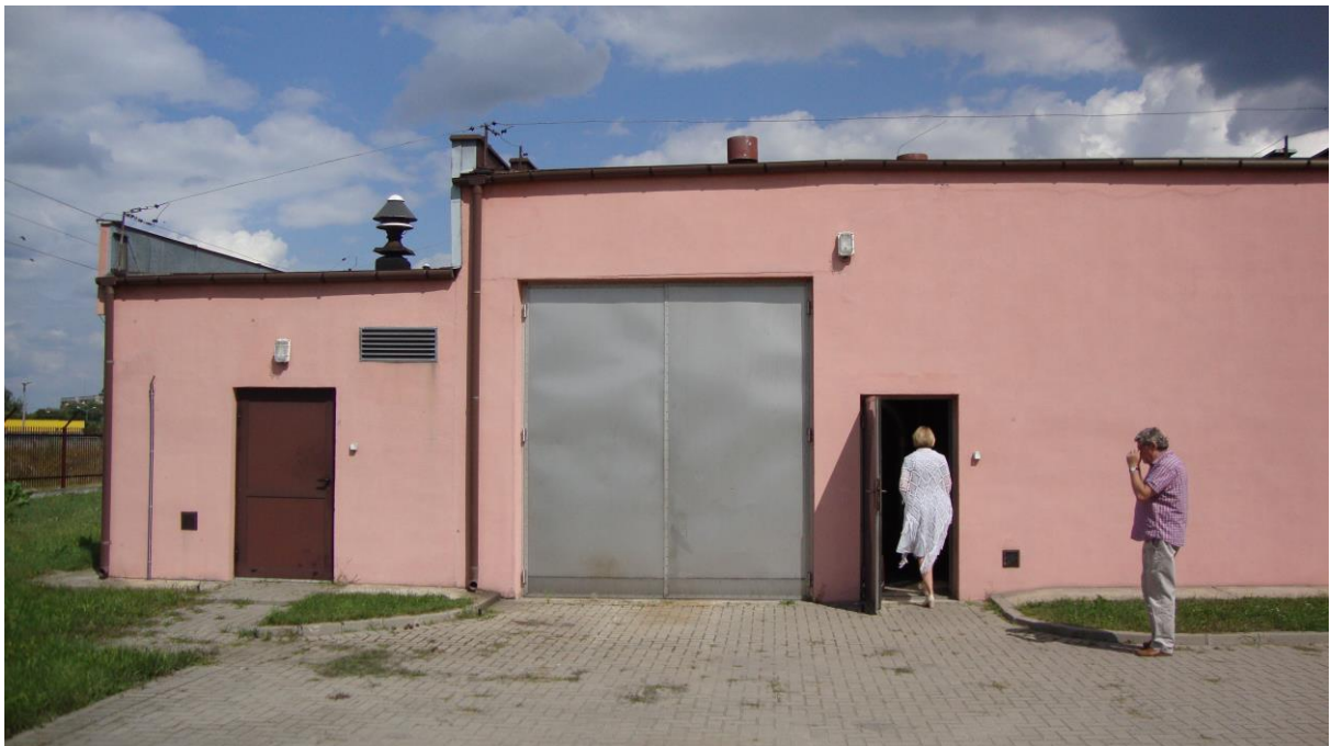
Fot. Nr32 – Budynek Pompowni Gdańska elewacja południowa
