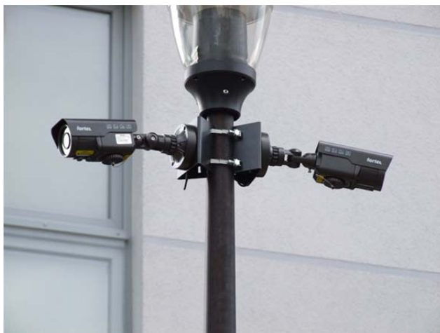
Przykładowe mocowanie kamer ze zintegrowaną obudową z wbudowanym promiennikiem IR
