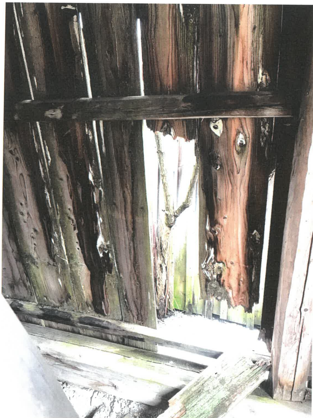
13. Zniszczenie i ubytki w dolnych partiach deskowania- widok z wnętrza dzwonnicy (fot. S. Kasprzak, marzec 2021r.)
