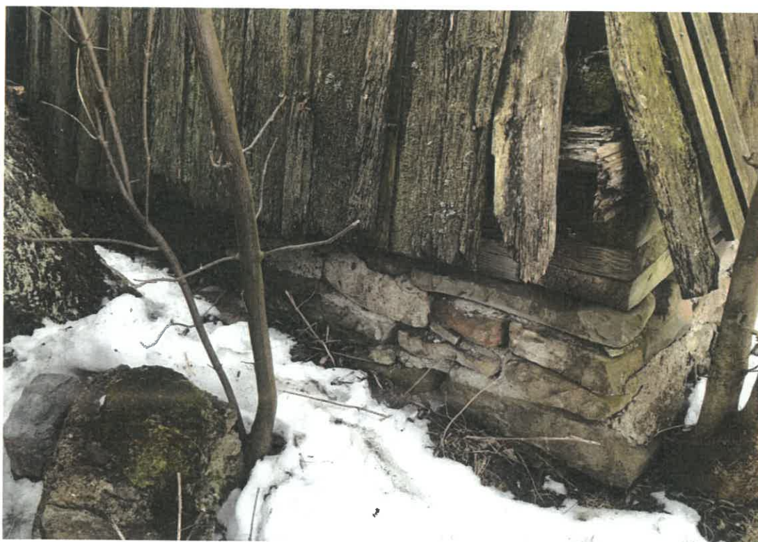
11. Porażenie deskowania przez glony. (fot. S. Kasprzak, marzec 2021r.)
