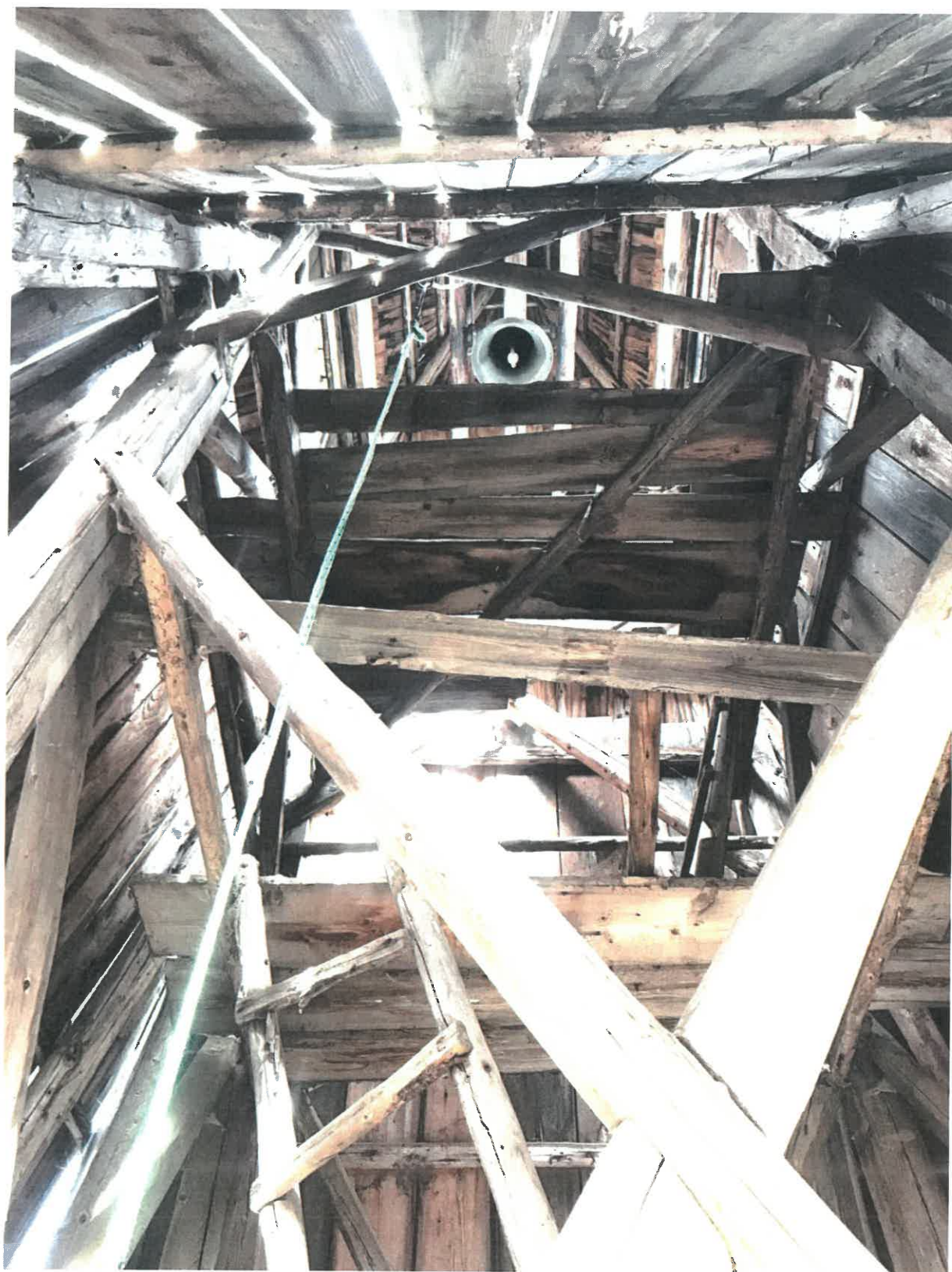
9. Konstrukcja słupowa dzwonnicy z podestami. (fot. S. Kasprzak, marzec 2021r.)
