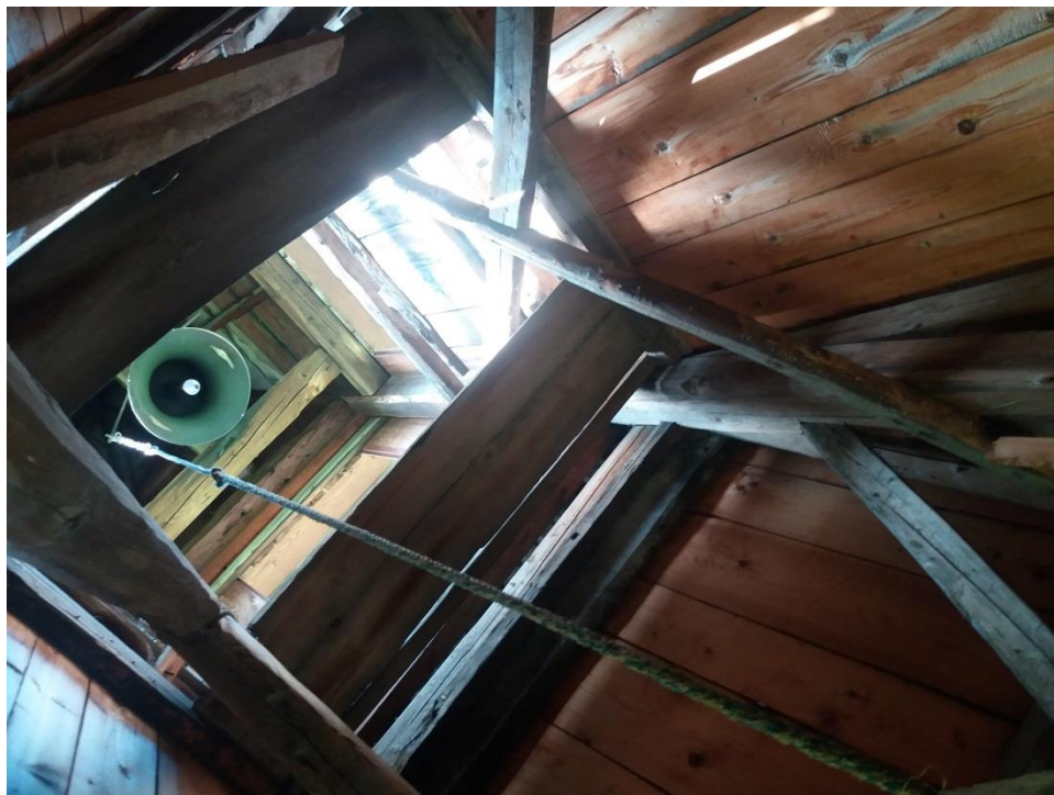
11. Konstrukcja słupowa dzwonnicy z podestami. (fot. S. Kasprzak, sierpień 2023r.)
