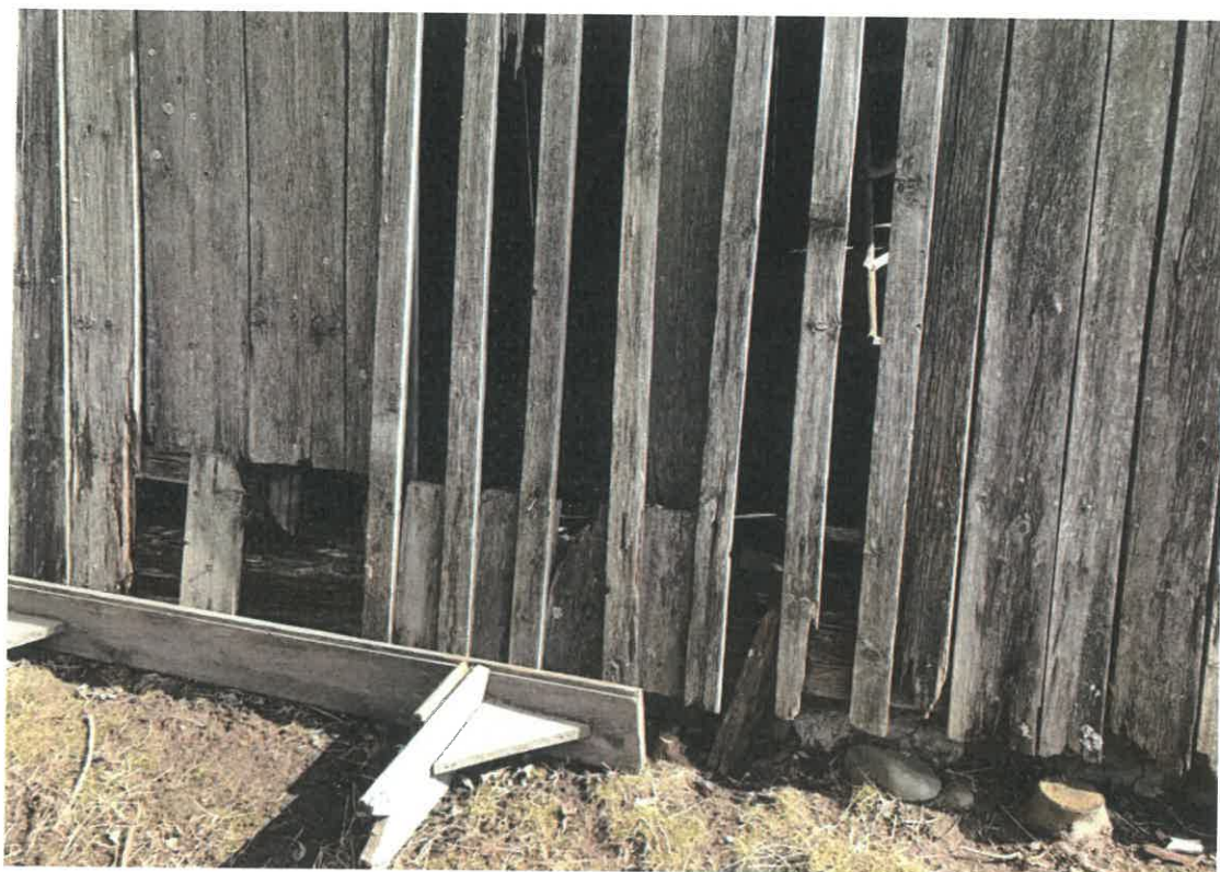
10. Zniszczenie i ubytki w dolnych partiach deskowania. (fot. S. Kasprzak, marzec 2021r.)
