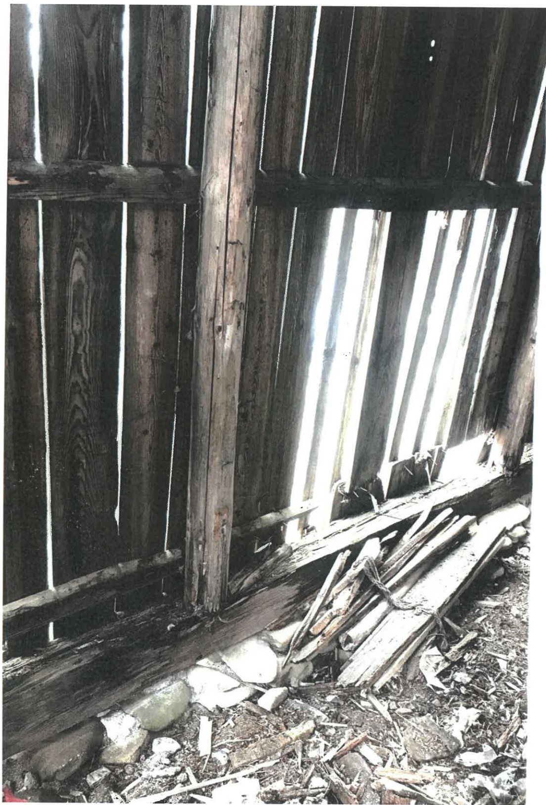
12. Zagrzybienie, spróchnienie i degradacja belki podawlinowej. (fot. S. Kasprzak, marzec 2021r.)
