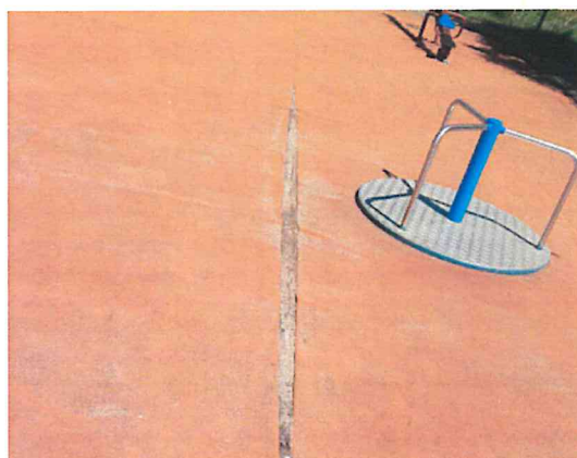
Fot. 4-7 – Uszkodzenia nawierzchni i istniejących elementów plac zabaw
