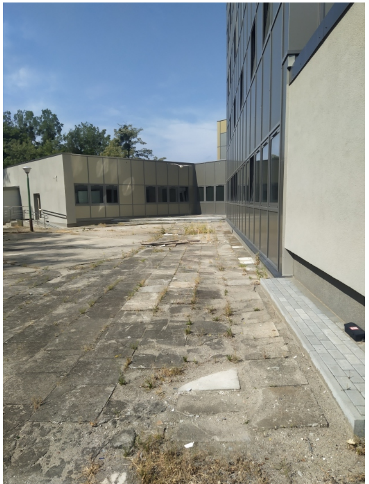
12.Nawierzchnia ist. betonowa drogi do remontu i chodnika z płyt betonowych
