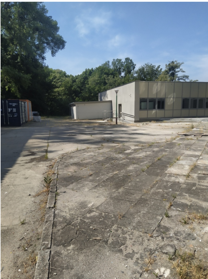
11.Nawierzchnia ist. betonowa drogi do remontu i chodnika z płyt betonowych
