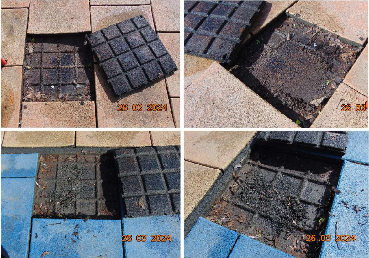
Fot. 6 Widok stanu nawierzchni bezpiecznej i warstwy podkładowej.
