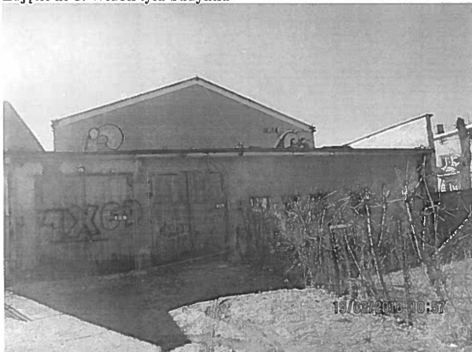
Zdjęcie nr 5. Widok tyłu budynku
