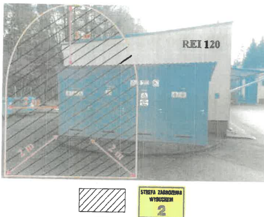
Rysunek 36. Wiata magazynowa butli z gazami technicznymi.
