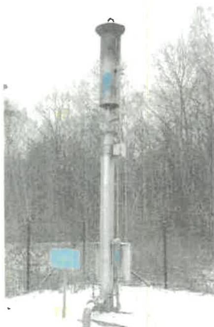
Rysunek 25. Pochodnia biogazu.
