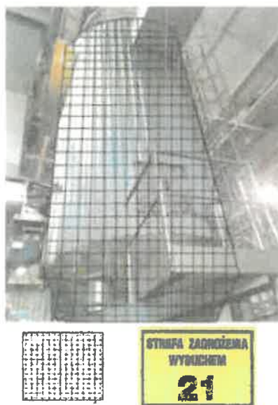
Rysunek 31. Silos osadu wysuszonego.
