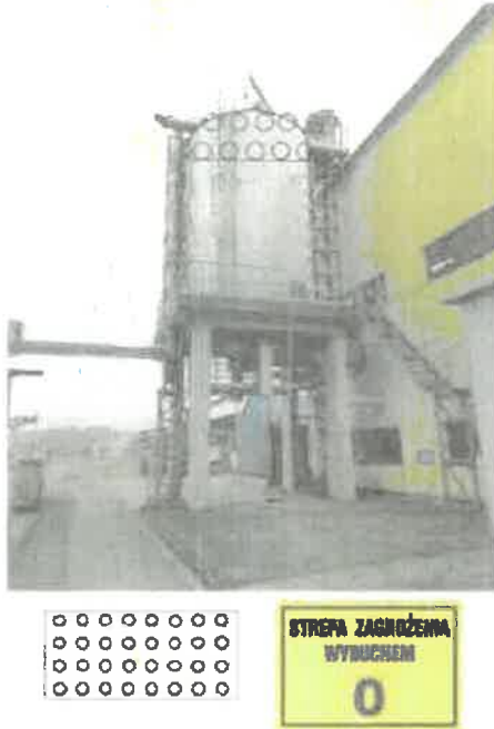
Rysunek 28. Silos magazynowy odwodnionego osadu.
